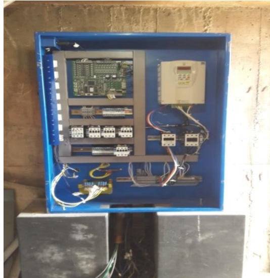
Figura 35: Fijación de Control Nuevo en Obra.
