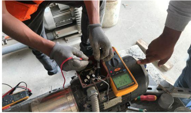
Figura 19: Medición de Aislamiento en Motor.
