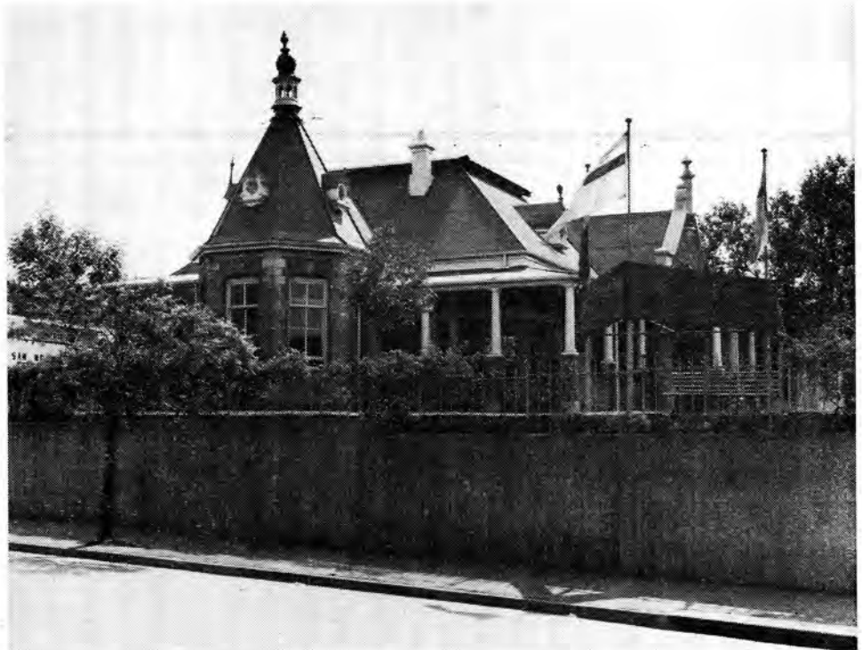
Hierdie gebou, wat tans as werwingskantoor S.A.W. in gebruik is, was lt.-kol. S. P. E. Trichardt, kommandant van die Korps Staatsartillerie, se ampswoning. Foto: Militêr-Historiese en Argivale Dienste.
