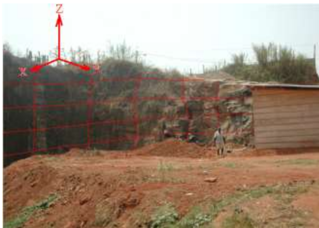
Figure 16 : Carroyage suivant les fissures sur l'affleurement de la Cité-Verte (près du mont Messa : N03^{\circ}52'37,8'' ; E11^{\circ}28'49,0'' ; H = 813\text{ m} )
