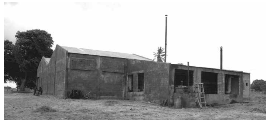
Photographie 1. Vue générale du bâtiment principal de l'usine
