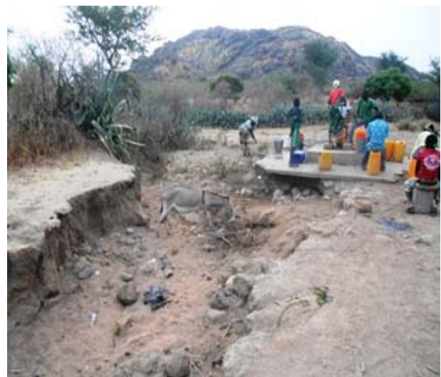
Figure 5: Impact des pluies intenses sur l'infrastructure d'un forage
