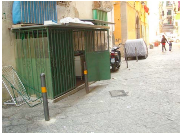
Fig. 2.30. Véranda métallique et plots de démarcation
