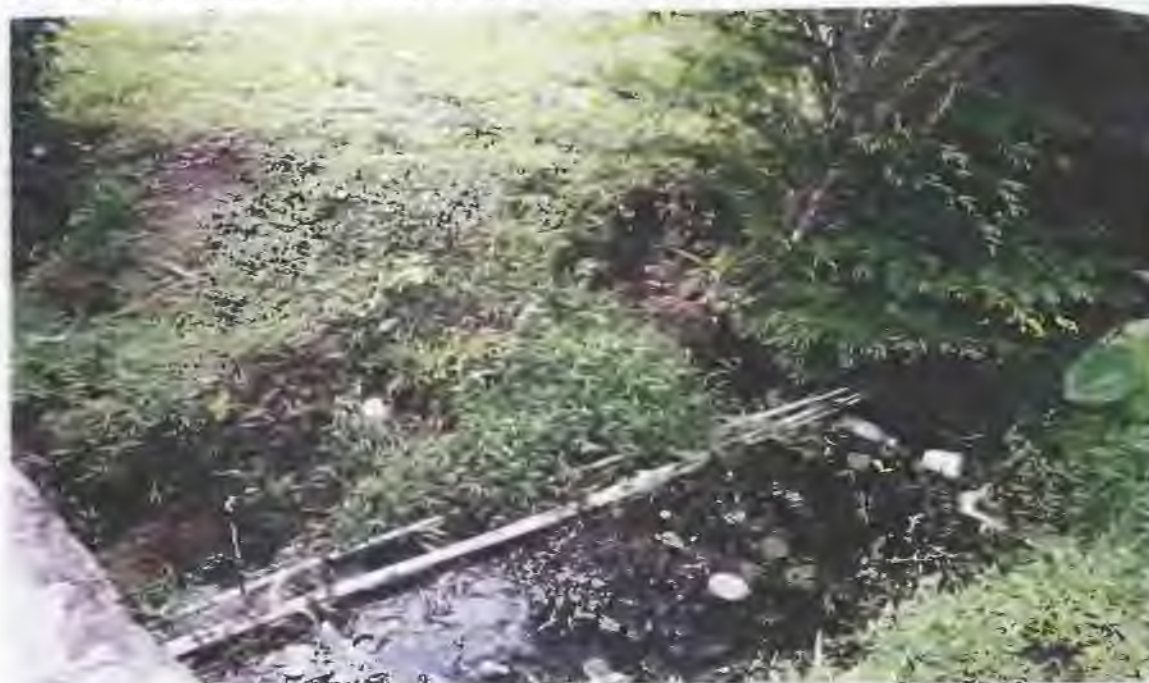
Figura N°36 DESECHOS SÓLIDOS A LO LARGO DE LA CARRETERA
