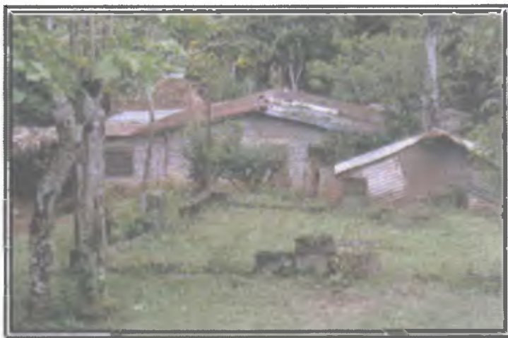
Figura 6: viviendas en El Peñón en condiciones inadecuadas
