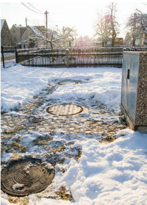
Öffentliche Gruppenkläranlage in Frohburg, Ortsteil Frauendorf (Kapazität: 50 EW) Aufgabenträger: Versorgungsverband Grimma-Geithain (VVG), Betriebsführer: Veolia Wasser Deutschland GmbH
