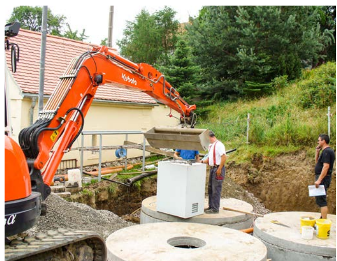
Bau der Gruppenkläranlage der Abwasserzweckgemeinschaft Oberdorf Spechtritz in Rabenau im Juli 2008 (Kapazität: 49 EW) Aufgabenträger: AZV Oelsabachtal
