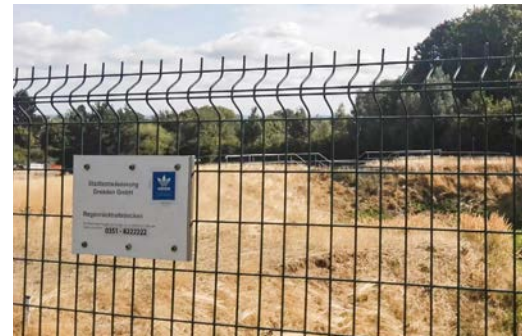
Regenrückhaltebecken der Stadtentwässerung Dresden GmbH im westlichen Stadtgebiet von Dresden
