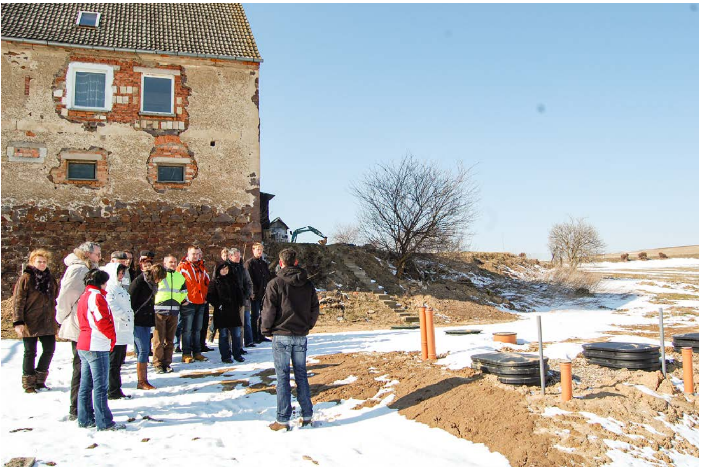
Inbetriebnahme der öffentlichen Gruppen-Kleinkläranlage „Klärchen“ in Leisnig, Ortsteil Altenhof (12 EW); Aufgabenträger: AZV Leisnig
