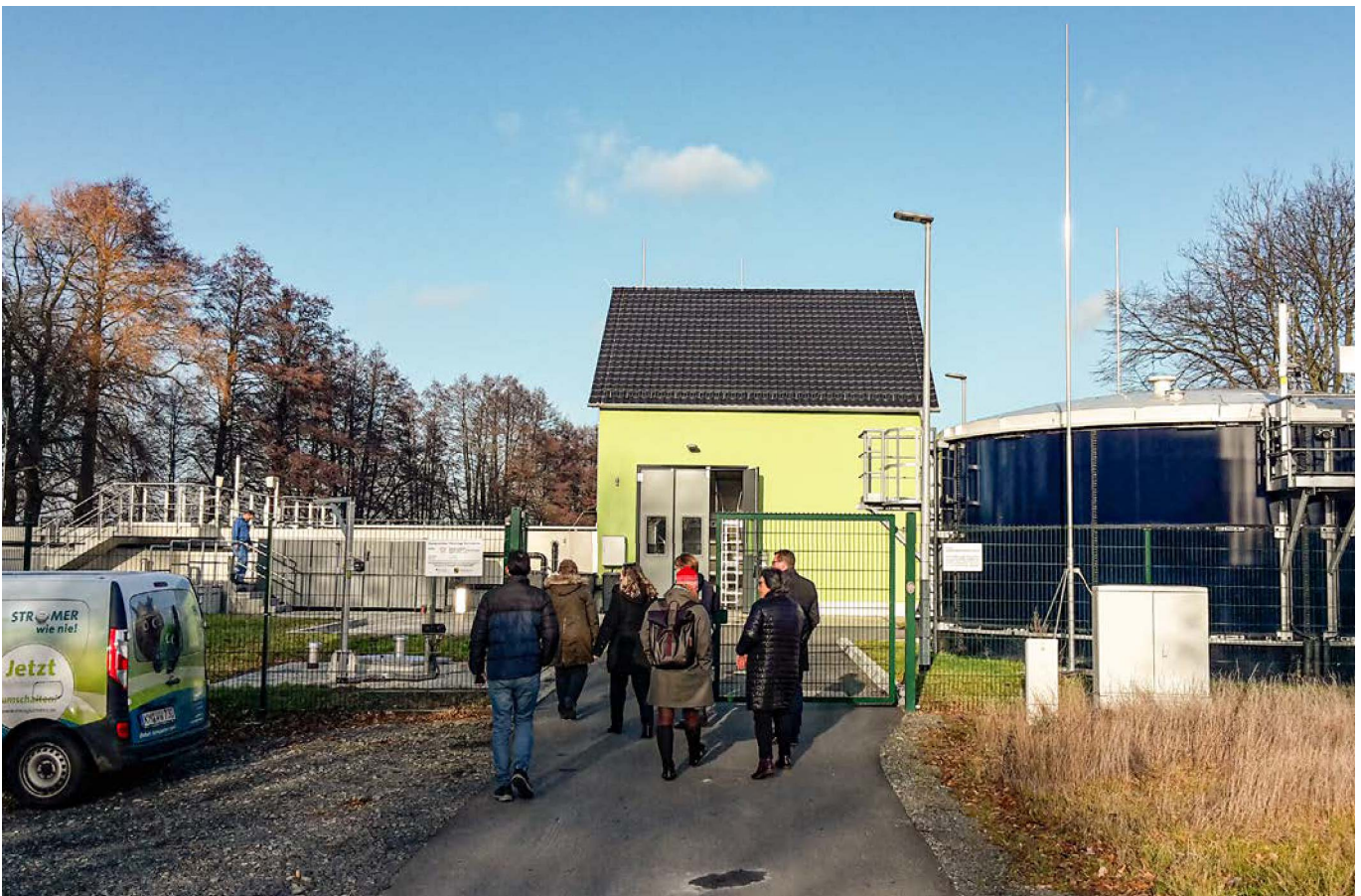
Kläranlage Schwepnitz (Kapazität: 2.200 EW) mit nachgerüsteter Stickstoff- und Phosphorreinigungsstufe, Aufgabenträger: Gemeinde Schwepnitz
