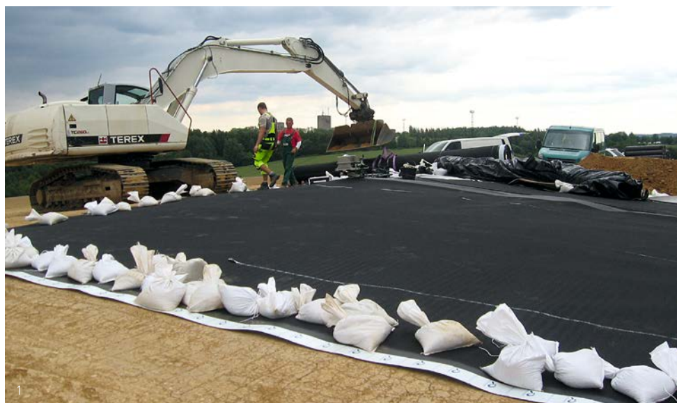
1) Einbau der Oberflächenabdichtung
