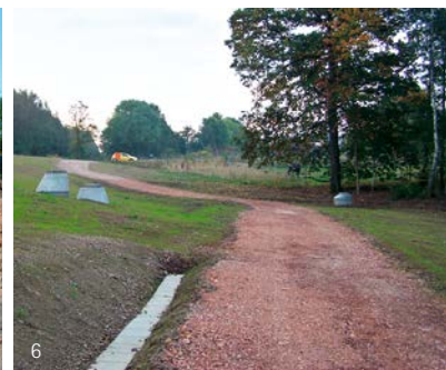
3) Steinkohlenmahlwerk – Trockenrömel mit Rauchreinigung; 4) Aushub und Abtransport des kontaminierten Materials; 5) Fund einer fünf Zentner schweren Fliegerbombe; 6) Sanierte Aschedeponie mit Weg, Entwässerungsgraben, Drainageschächten
