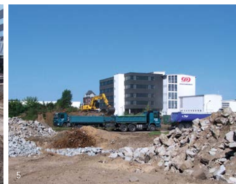
2) Demontage der Hochtanks; 3) Abbruchmaterial ehemalige Kfz-Waschanlage; 4) Aushubarbeiten Sanierungszone I; 5) Entsorgung des Abbruchmaterials
