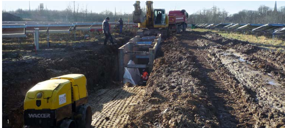
1) Bau der Infiltrationsrigole
