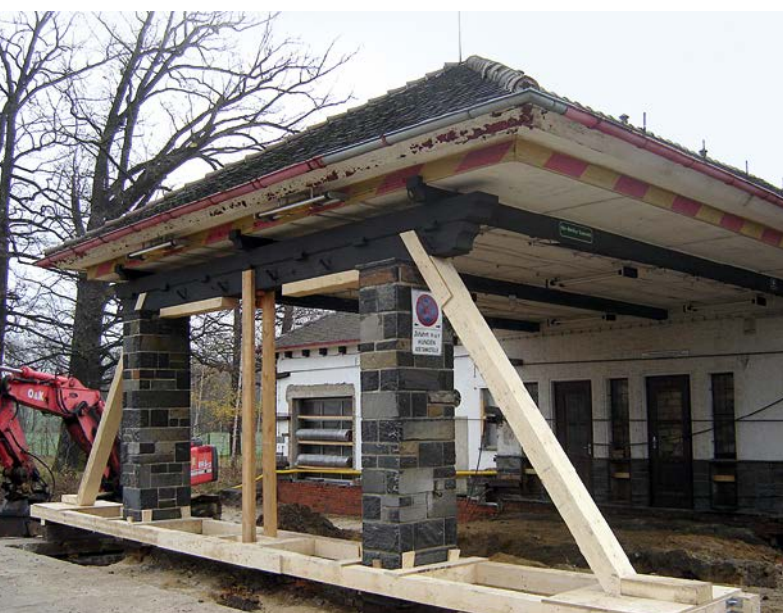
Abbildung 5: Bodensanierung im Bereich eines denkmalgeschützten Tankstellengebäudes
