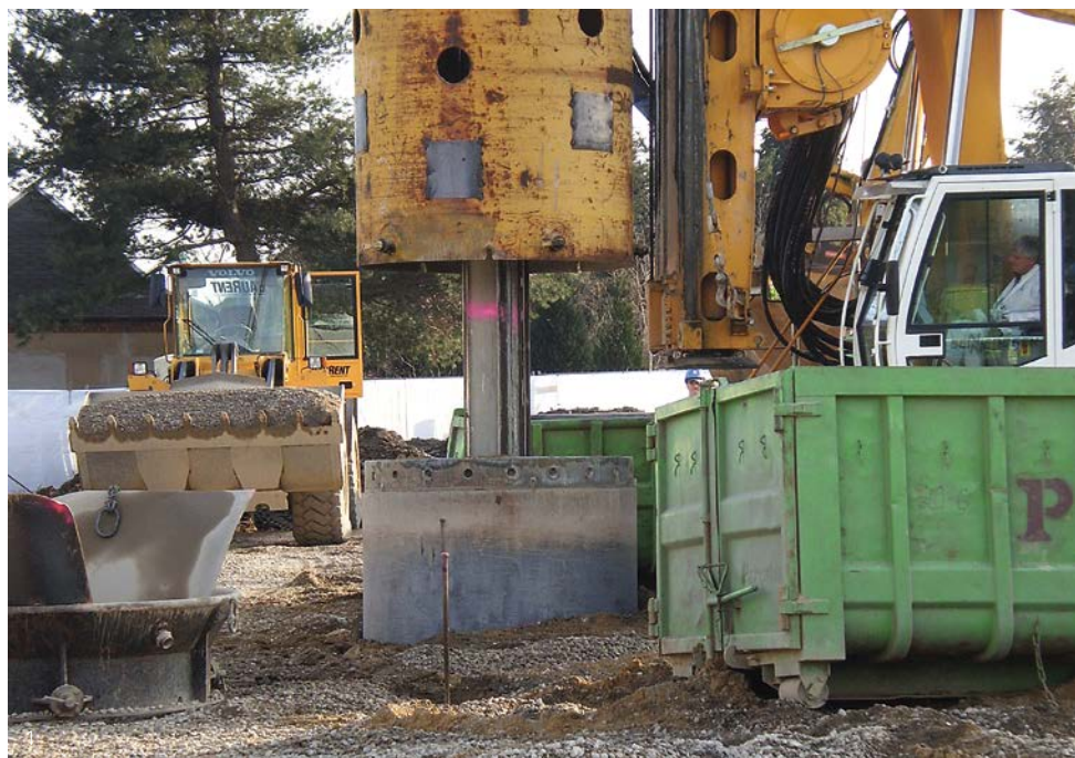
1) Abteufen einer Großlochbohrung (rechts) und Verfüllung einer anderen mit Kies (links)
