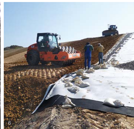
2) Schweißgerät für die Kunststoffdichtungsbahnen; 3) Schichtenaufbau der Oberflächenabdichtung; 4) BHKW-Gasfackel; 5) Bautafel; 6) Einbau der mineralischen Dichtung
