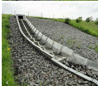
2) ehemalige Sonderabfalldeponie, 3) Phasenabschöpfung, 4) Oberflächenwasserfassung Auflandebecken, 5) Grundwasserreinigung
