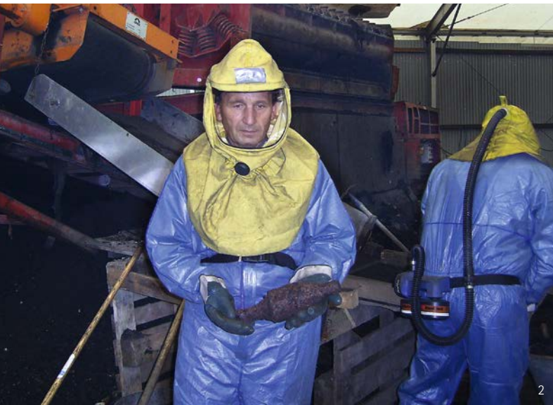
2) Die Munitionsbergung stellte hohe Anforderungen an die Arbeitssicherheit, da sich im Haldenmaterial auch explosive Sprengstoffreste und scharfe Munition befanden. Das Baupersonal trug Schutzanzüge und der Radlader wurde mit einem Splitterschutz ausgerüstet.; 3) Vor Beginn der Sanierung wurde die Baustelle eingehaust und eine Abluftanlage installiert.; 4) Eingehauste Brandplatzhalde
