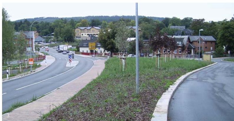
2) Teergrube – Füllmaterialien: Teerphase, Bauschutt; 3) Situation nach dem Abschluss der Sanierung und des Straßenbaus
