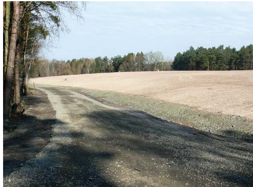
4) Oberfläche nach Fertigstellung
