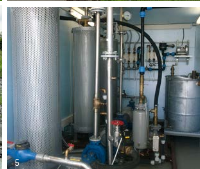
2) ehemalige Sonderabfalldeponie, 3) Phasenabschöpfung, 4) Oberflächenwasserfassung Auflandebecken, 5) Grundwasserreinigung
