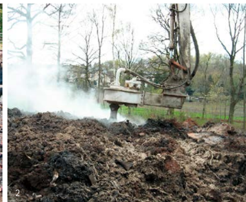
2) Einmischen von Asche in das aufgeweichte Material
