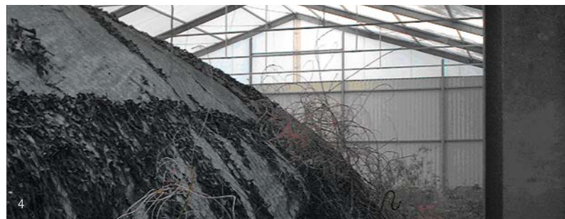
2) Die Munitionsbergung stellte hohe Anforderungen an die Arbeitssicherheit, da sich im Haldenmaterial auch explosive Sprengstoffreste und scharfe Munition befanden. Das Baupersonal trug Schutzanzüge und der Radlader wurde mit einem Splitterschutz ausgerüstet.; 3) Vor Beginn der Sanierung wurde die Baustelle eingehaust und eine Abluftanlage installiert.; 4) Eingehauste Brandplatzhalde
