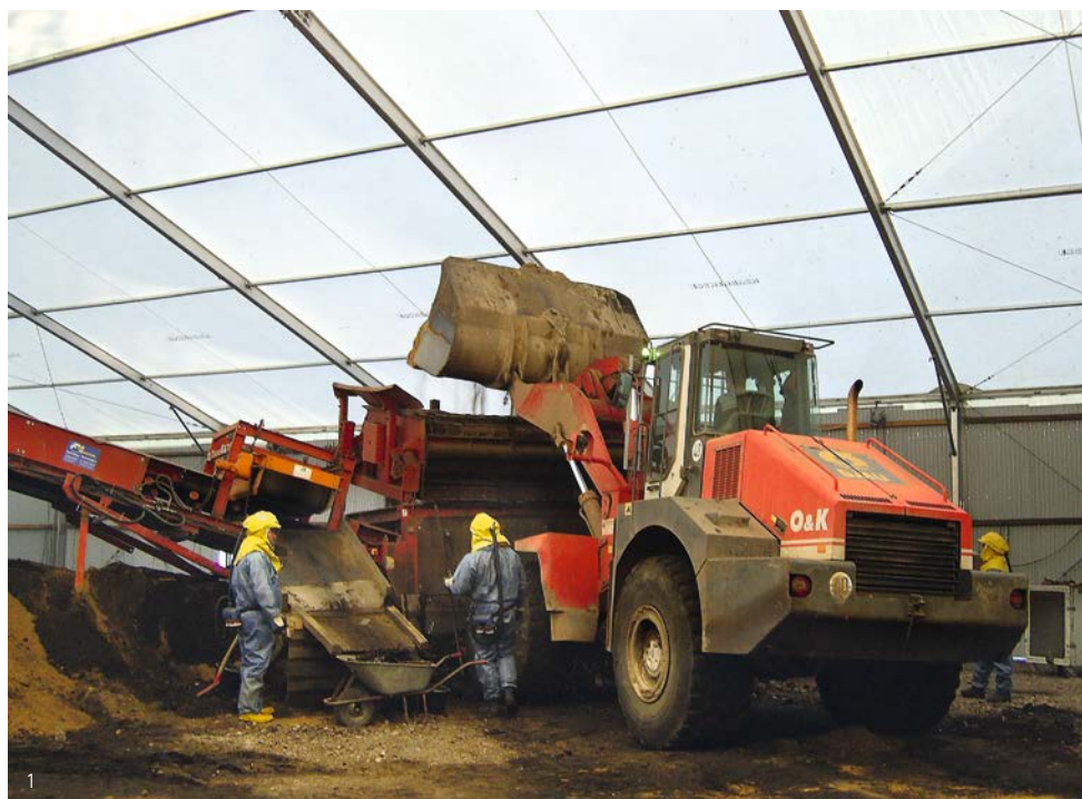
1) Das Haldenmaterial wurde gesiebt und mit Hilfe eines Magnetabscheiders von Munitionsresten befreit.
