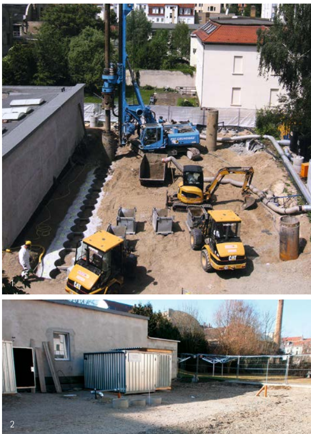
1) Großlochbohrverfahren im Rahmen der Sanierungsphase 1; 2) Der Standort während der Sanierungsphase 2
