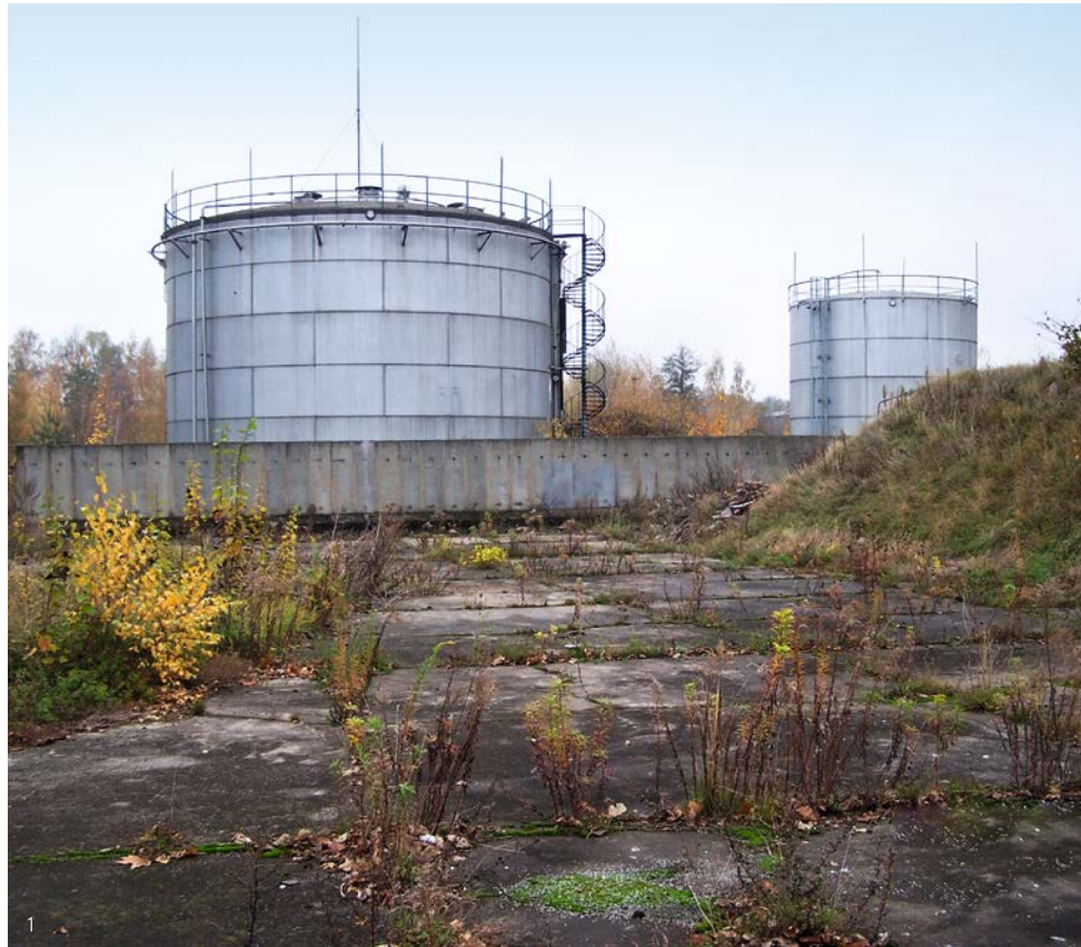
1) Hochtanks auf dem Gelände des ehemaligen Tanklagers
