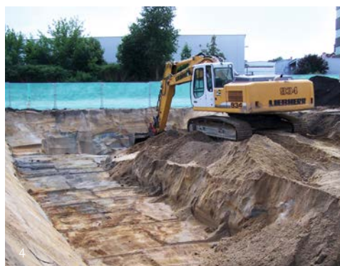
2) Demontage der Hochtanks; 3) Abbruchmaterial ehemalige Kfz-Waschanlage; 4) Aushubarbeiten Sanierungszone I; 5) Entsorgung des Abbruchmaterials
