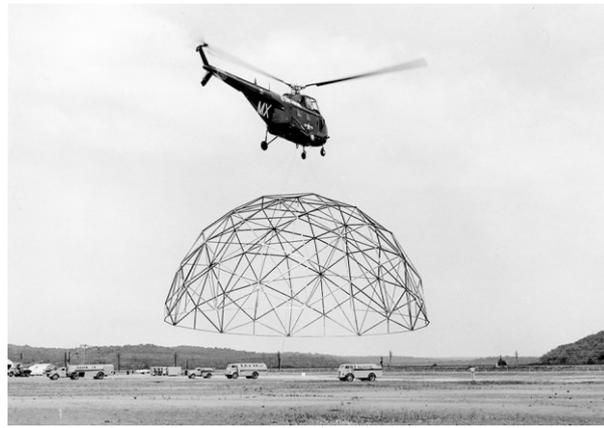
Abb. 3: R. Buckminster Fuller, Geodesic Dome, vom US Marine Corps per Hubschrauber transportiert, 1954.
