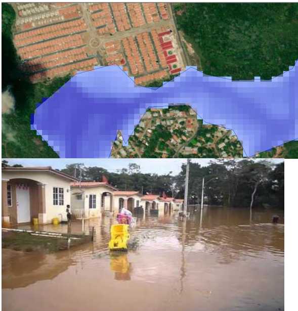
Punto 2. El Trapichito: Los Flamingos Tanto la simulación como la fotografía muestran la salida del río de su cauce natural afectando el área de la Planta de Tratamiento de Aguas Residuales.
