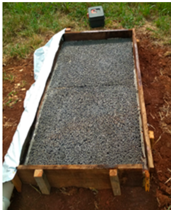
Figura 9. Modelo de pavimento de concreto permeável instalado
