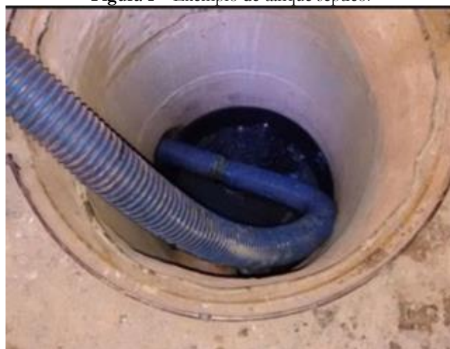
Figura 1 – Exemplo de tanque séptico.
