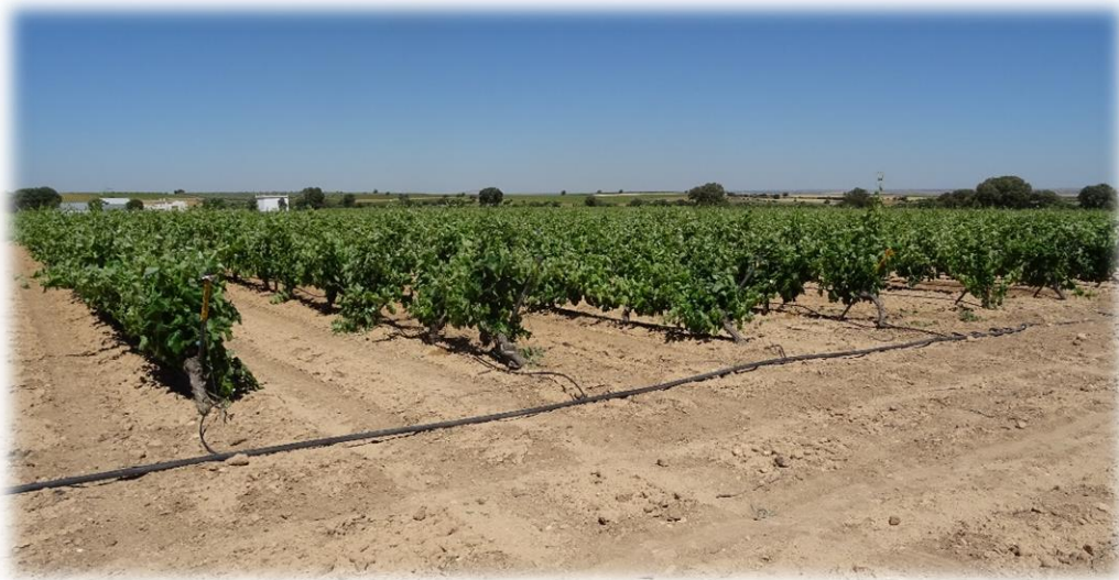
Figura 12. Imagen de la disposición de la tubería principal y los ramales de riego por goteo en la parcela de la variedad Macabeo.
