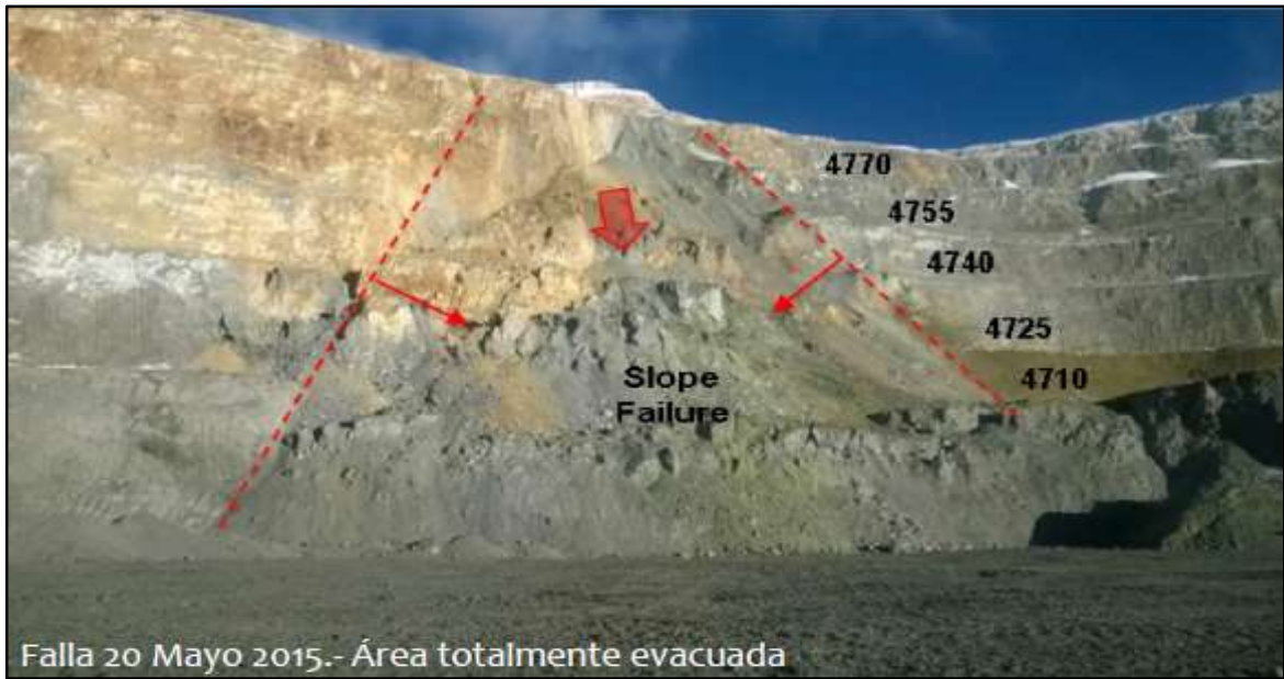
Figura 39. Deslizamiento de Talud Tomado de Geotécnia mina – Empresa “x”
