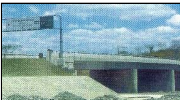
Reconstrucción del Puente Río Negro
