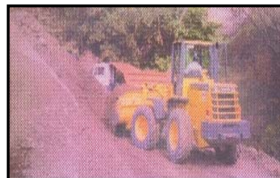
Maquinaria del Proyecto “Brigada de mantenimiento de caminos”
