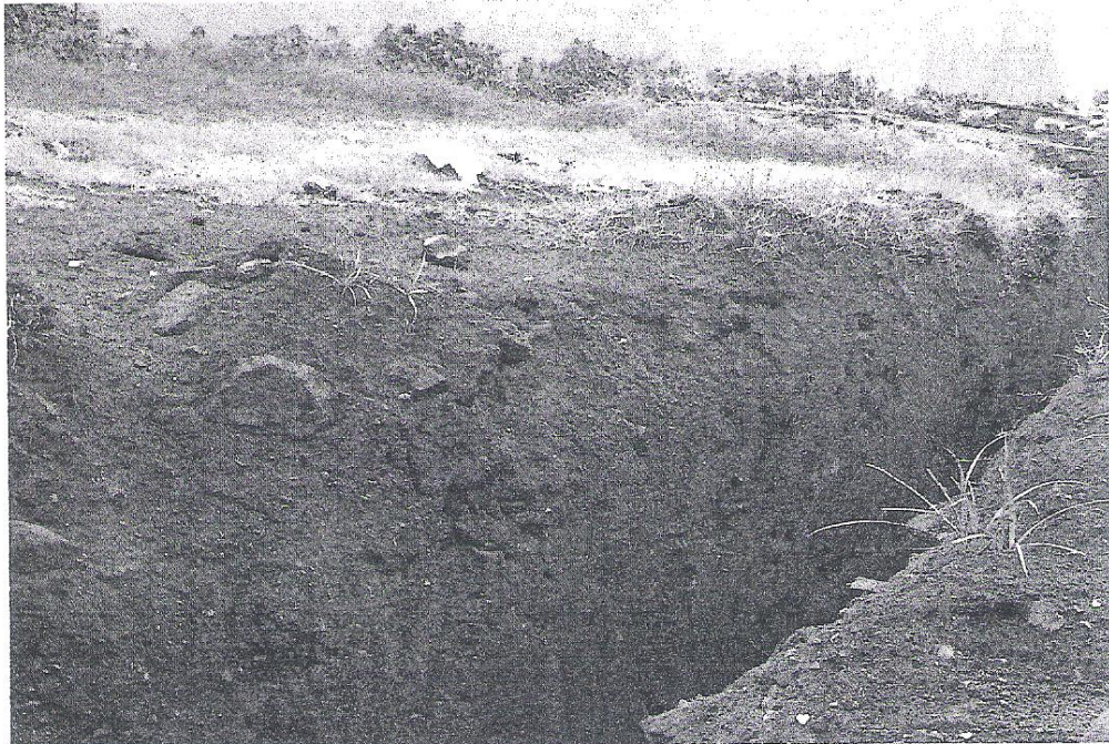
Foto 1: Vista panorámica de la trinchera, Proyecto EXIMOSA, Reparto Tiscapa.
