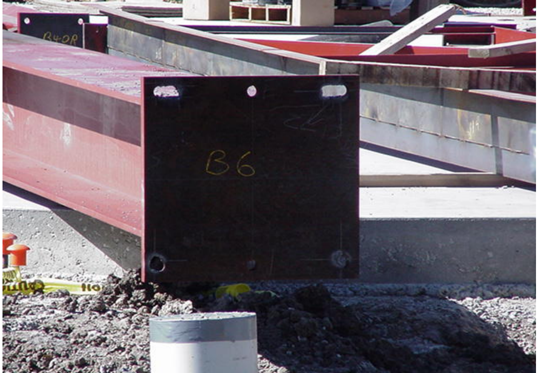
Placa de Base con Agujeros para Pernos de Anclaje
