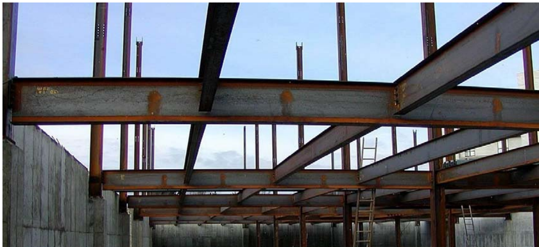
Viguetas tipo H sobre las trabe
