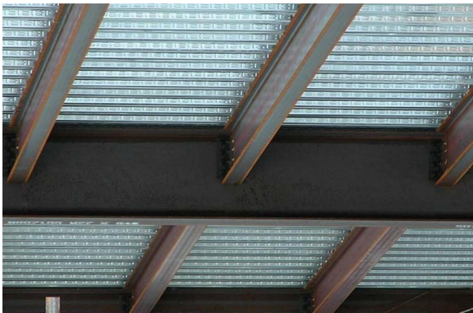
Carga Muerta situada sobre las Viguetas
