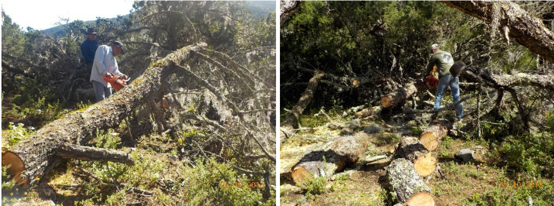
Figura 6. Derribo y troceo del arbolado infestado, material que permanece disponible en el área para realizar barreras de material muerto conforme a las curvas a nivel.
