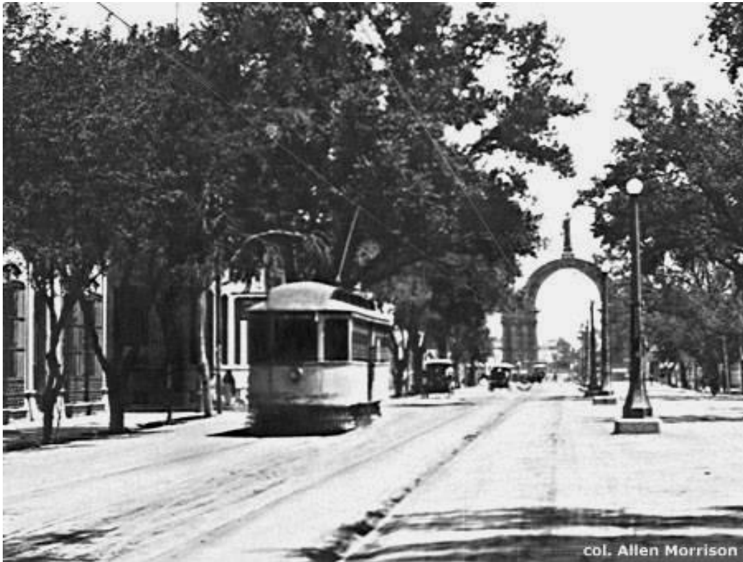
Imagen 2.- Tranvía cerca de la Calzada Unión y Calzada Progreso (Actualmente Calzada Madero y Avenida Pino Suárez). Circa 1930. Fuente: Colección Allen Morrison.
