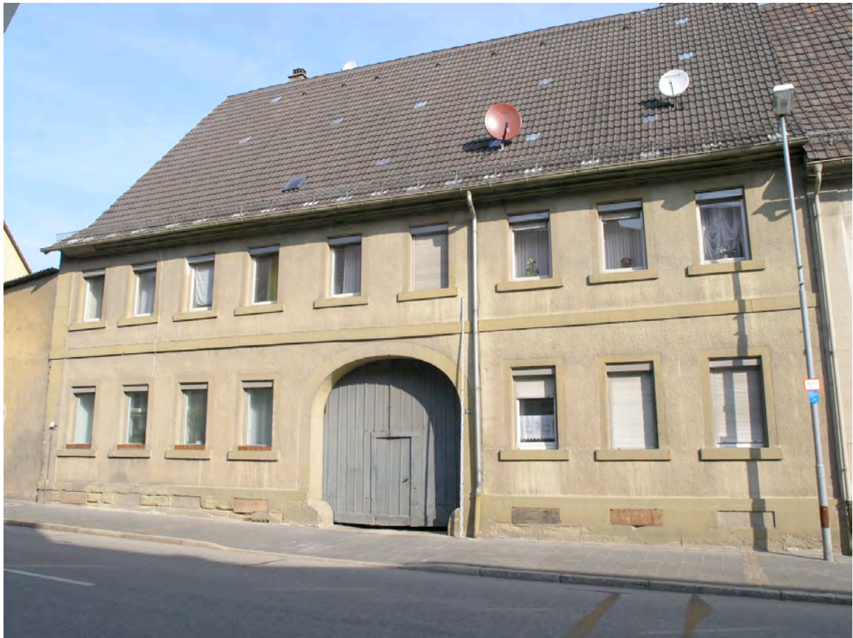
Abbildung 78: Südfassade Haupthaus A der Liegenschaft Frey
