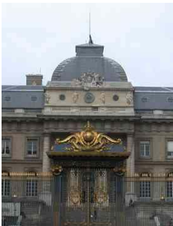
Fig. 5. Vue de la façade du palais de Justice de Paris
