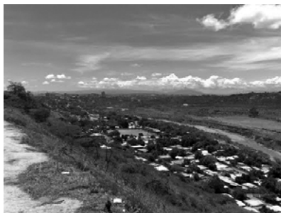
Figura 6.11 Viviendas ubicadas en el barrio Santo Domingo (margen izquierda) del río Turbio, ubicada sobre la segunda terraza del río. Fotografía de los investigadores en actividad de campo, 2016
