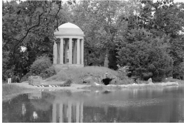
1 Deichverteidigungsmaßnahmen am Venustempel während des Sommerhochwassers 2013.
