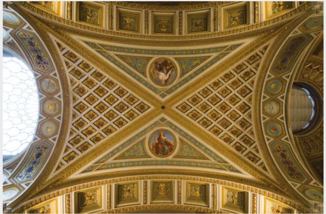
Fig. 18 Particolare della copertura della sala quadrilatera. Fig. 18 Detail of the ceiling of the quadrilateral hall.
