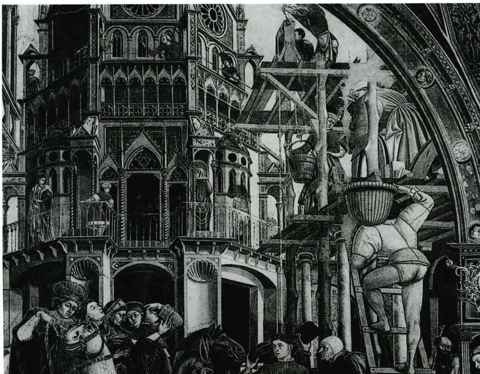
Rare exemple de chantier urbain, avec, à droite, des manoeuvres qui montent les matériaux sur un échafaudage très élaboré : il est de type encastrement, à un rang de perches. Celles-ci sont ici des troncs d'arbres à peine équarris, sur lesquels les départs des branches sont toujours visibles. Les plateaux sont constitués de planches juxtaposées qui reposent sur les boulins. Des cintres en charpente sont posés dessus en attente.
