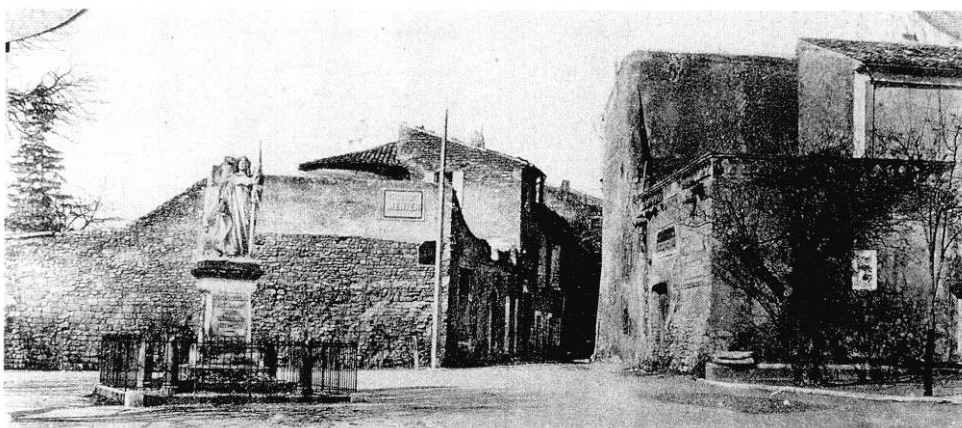
Le fragment de maçonnerie antique, visible au dernier plan, à droite du monument aux morts, se distingue nettement des reprises postérieures
