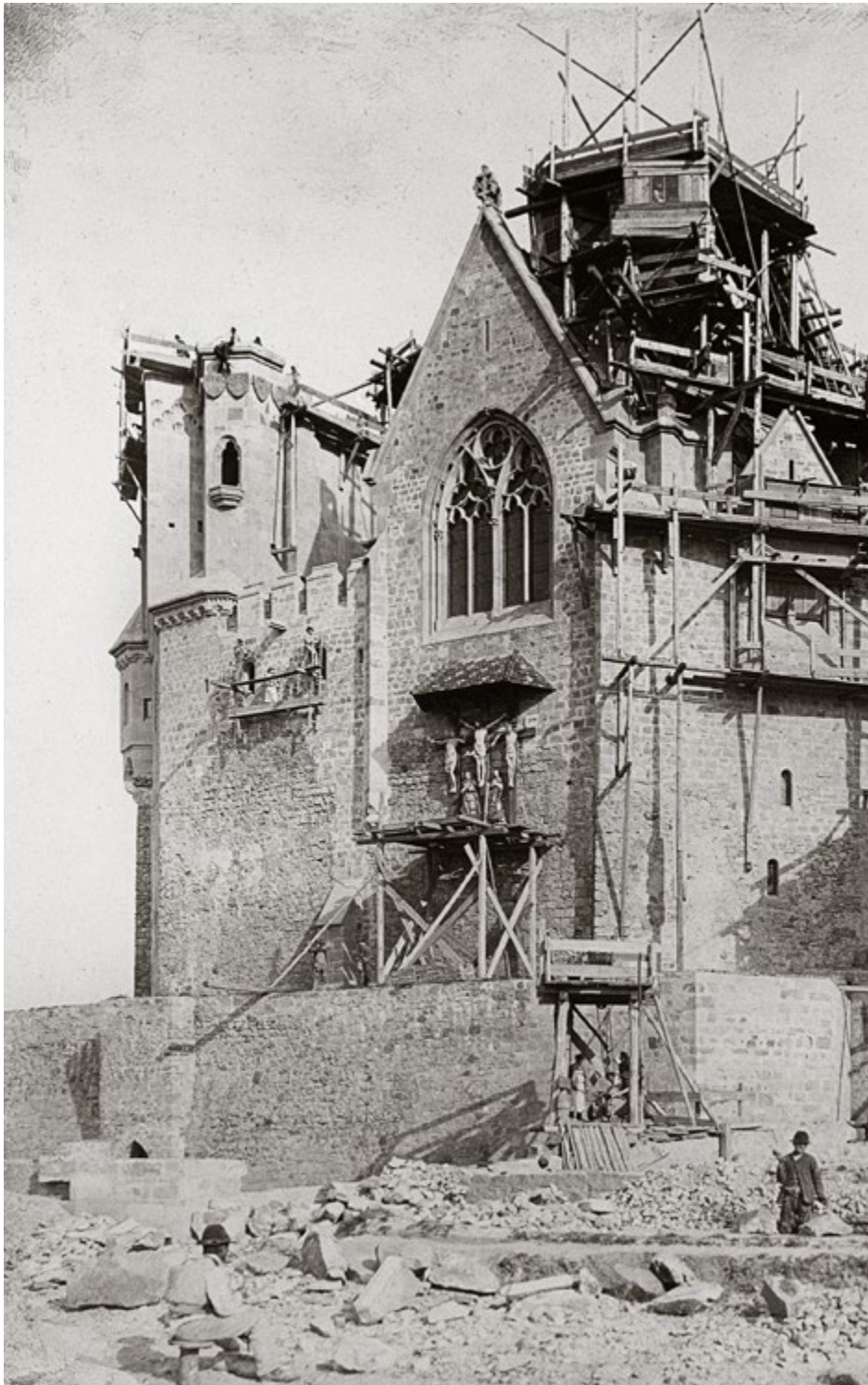
[[ 49 ]] Bau der Trakte im Westen, 1892
