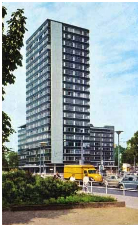
Abbildung 10: Zürich-Hochhaus, Frankfurt am Main 5
