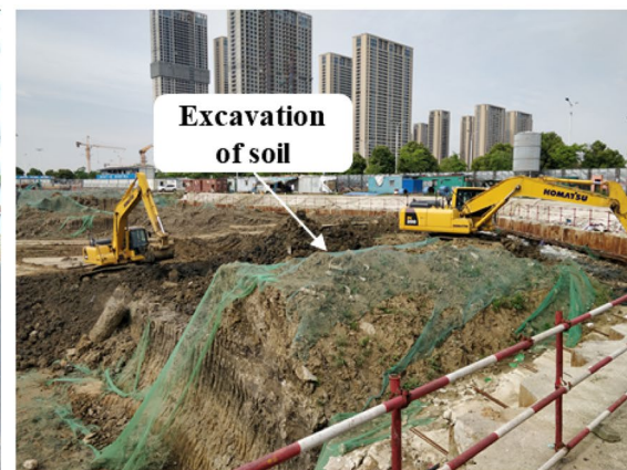
(d) Excavation of site
