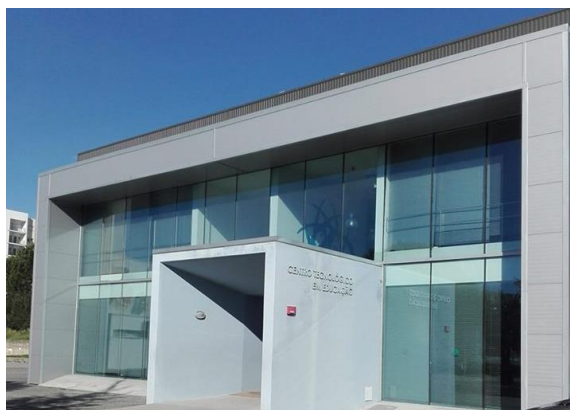
Figura 3: Fachada do CTE
