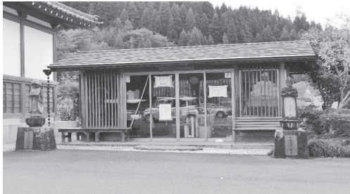
写真4-a エイズなどの伝染病を患っている猫のための隔離棟 〈2020年11月6日；著者撮影〉
