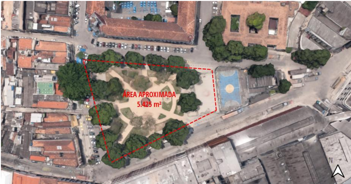
Figura 3: Vista da Área do Projeto
