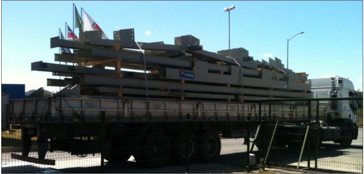
Figura 2.8 – Estruturas metálicas sendo transportadas em carretas convencionais.
