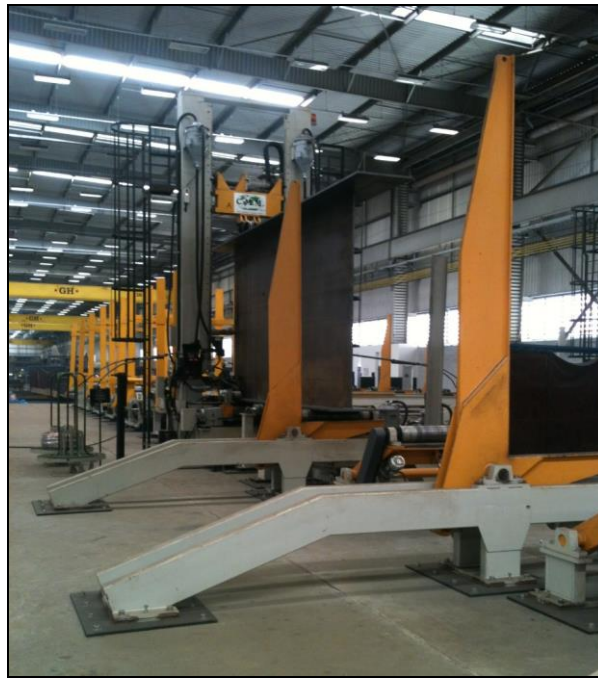
Figura 2.6 – Fabricação do perfil soldado da longarina de uma ponte em aço. Fonte: acervo técnico do autor.
