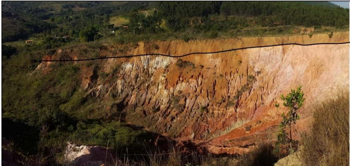
Figura 3.4 Situação atual do talude de jusante da voçoroca, com linha negra delimitando o horizonte B, pouco erodível, do C (saprolito), com muitos sulcos de erosão.
