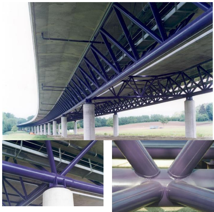
Figura 3.6 – Viaduto de Lully, Suíça. Fonte: http://www.dic-ing.ch/data/lully.pdf .
