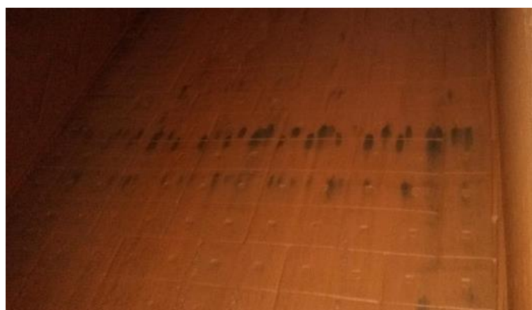
Figura 30. Revestimento UHMW aplicado em chute de undersize após 30 dias de operação.
