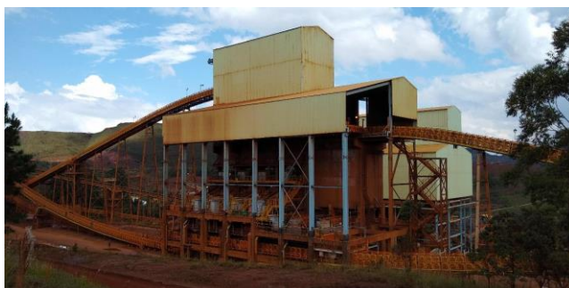
Figura 34. Instalação de tratamento de minério I (ITM-I) adaptada para processamento à umidade natural.
