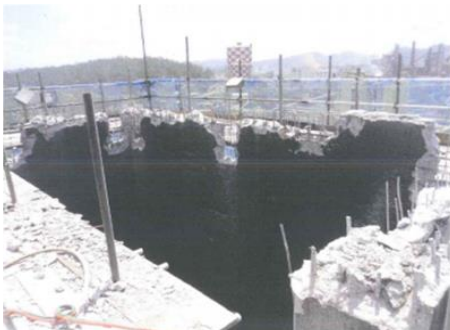
Figura 28 Demolição do topo da torre cercado pela tela de segurança
