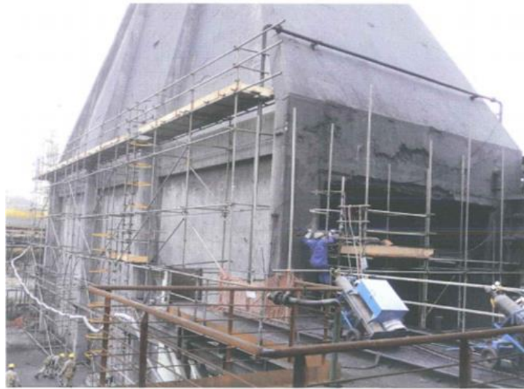
Figura 23 Montagem de Andaime tubular na torre de resfriamento
