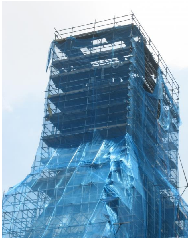
Figura 27 Estrutura do andaime
