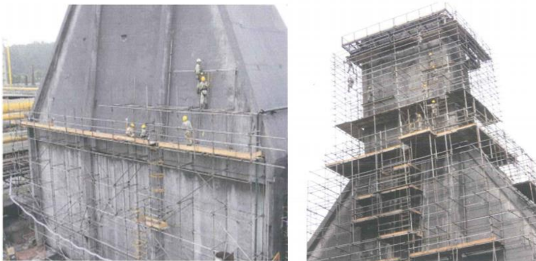
Figura 24 Montagem de Andaime tubular na torre de resfriamento
