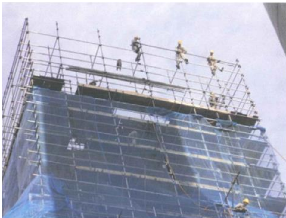
Figura 30 Desmontagem gradativa do andaime da torre
