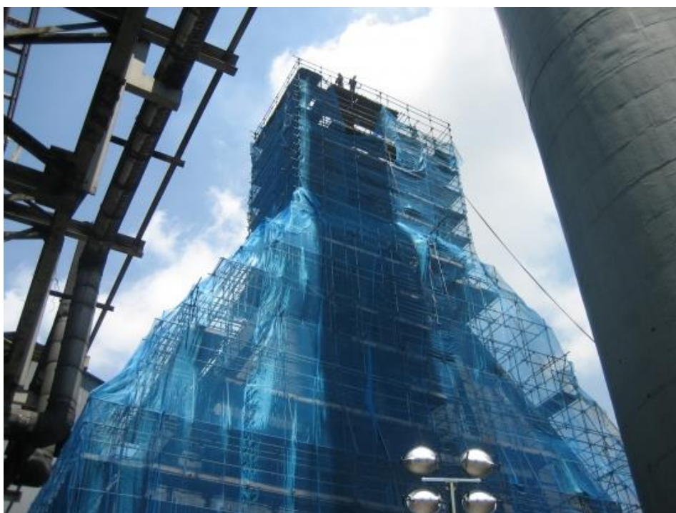
Figura 13 Construção do andaime para demolição da coqueria 2
