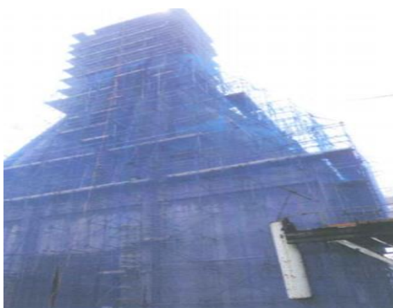
Figura 25 Montagem da tela de segurança na torre
