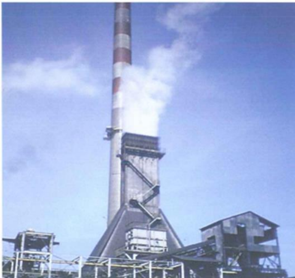
Figura 12 Aspectos da coqueria 2 anterior à demolição
