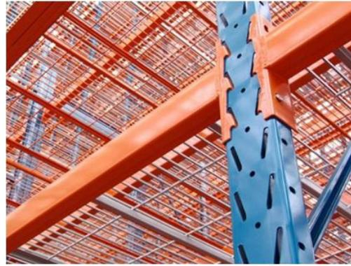
Figura 3 - Encaixe das vigas e pilares (Águia, 2013)
