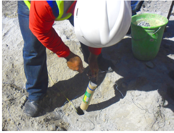
Figura 1: Operador inserindo dispositivos de detonação no furo de forma manual. (Desmontec, 2012)
