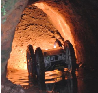
(a) Mina abandonada localizada em área de risco, Ouro Preto-MG
