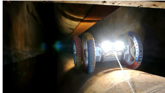
(b) Barragem de Rio Peixe, Itabira-MG
