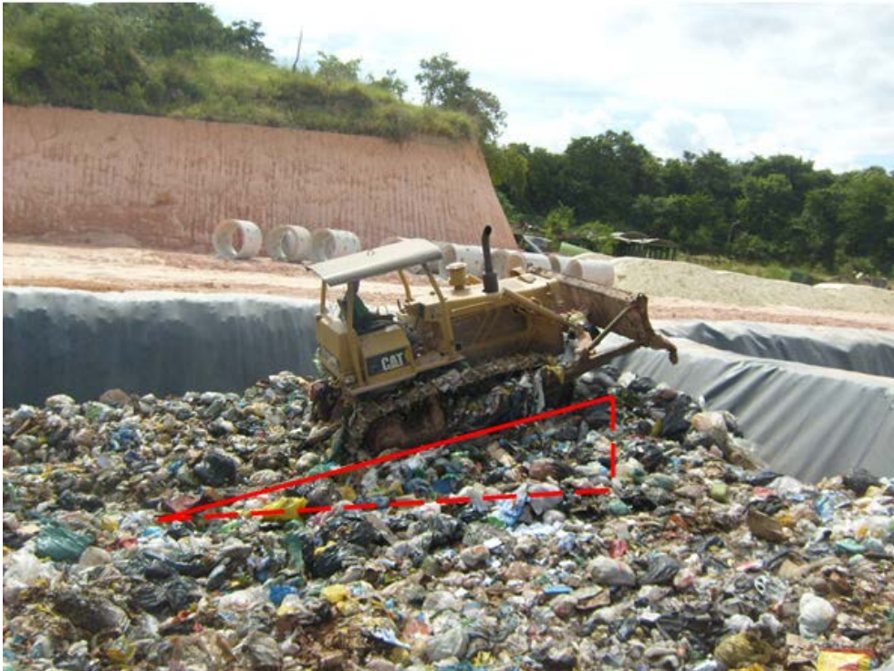
Figura 13 - Conformação e compactação dos resíduos
