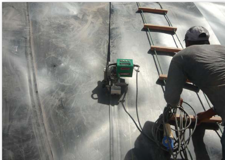
Figura 6 - Detalhe da solda entre os painéis de PEAD
