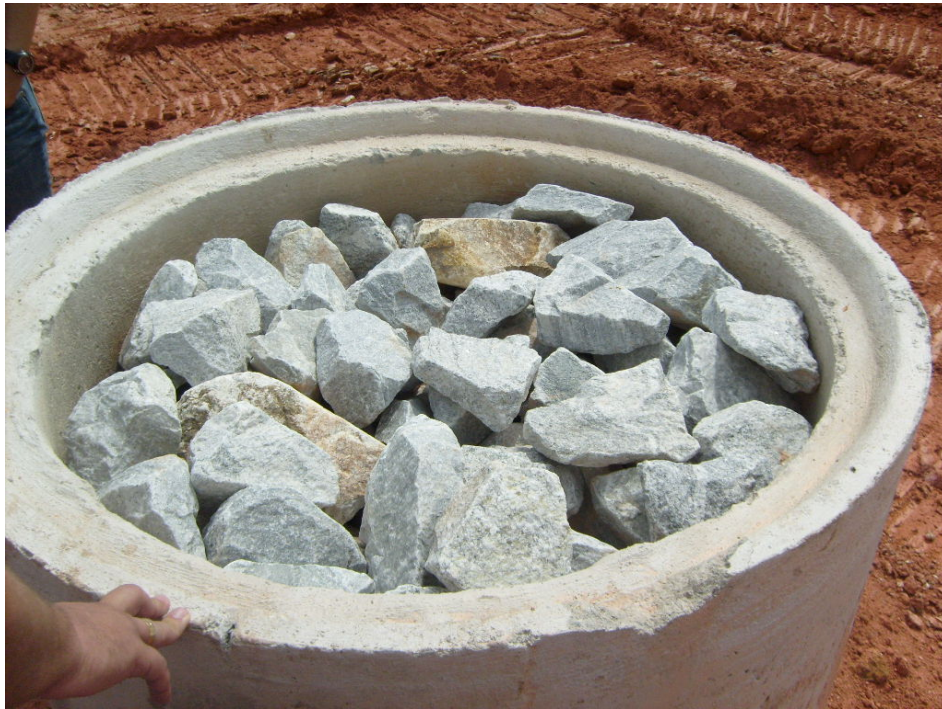
Figura 11 - Dreno de gás - manilha preenchida com pedra de mão
