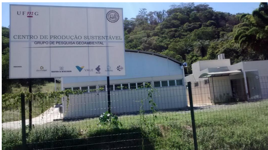
Figura 3.1 - Vista externa do Centro de Produção Sustentável da UFMG. Fonte: dados do autor, 2014.
