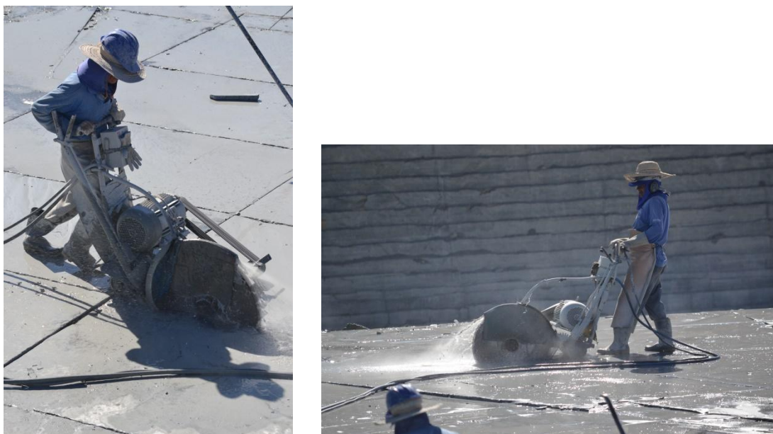
Figura 2.2 - Esquadreamento e uso de discos diamantados para corte de pranchões ou lajão. Fotos do autor, 2015
