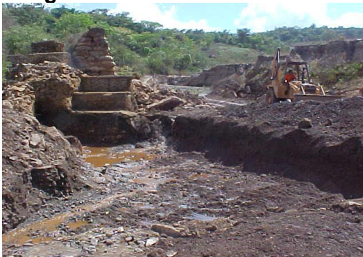
Figura 79 – Início das obras de recuperação e alteamento da Barragem de Gabião
