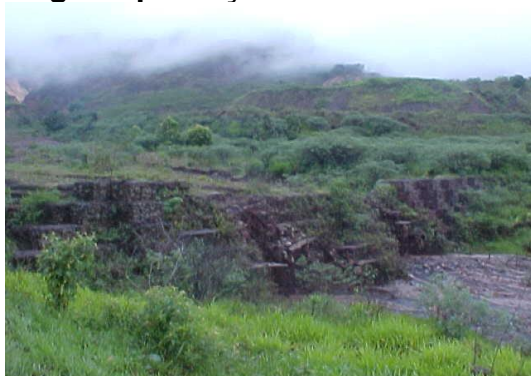
Figura 62 – Barragem de Gabião construída pela EMESA no leito do Córrego Esperança
