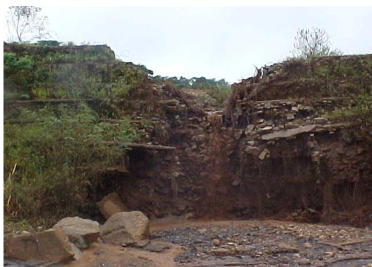
Figura 64 – Imagem ampliada de um dos pontos do rompimento da Barragem de Gabião
