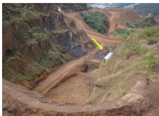
Figura 162 – Bacia de controle na saída da cava principal, logo abaixo da nascente do córrego esperança e imediatamente à montante da parte inicial da escada de descida d'água
