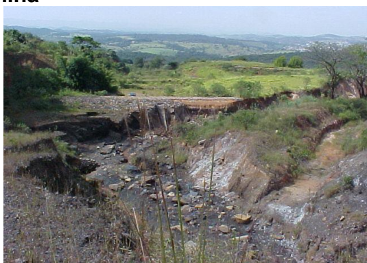
Figura 51 – Imagem um pouco à montante do barramento construído pela COPASA para desvio das águas provenientes do interior da cava da mina
