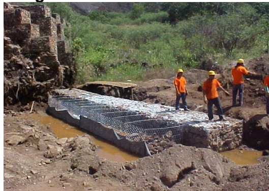
Figura 80 – Início das obras de recuperação e alteamento da Barragem de Gabião
