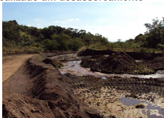
Figura 158 – Parte do leito do Córrego Elias (Cocho das Éguas), onde foi realizado um desassoreamento
