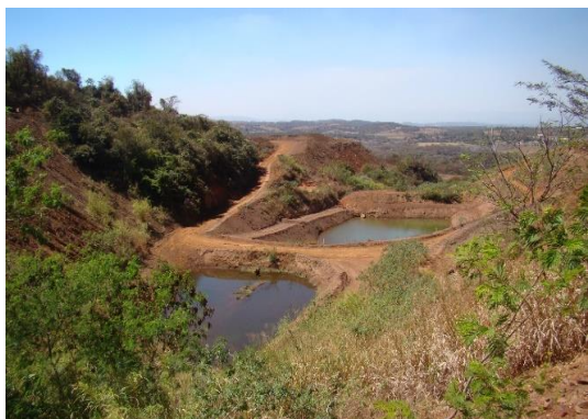
Figura 165 – Bacias de amortecimento de fluxo imediatamente à jusante da escada de descida d'água, cujo fluxo segue pelo canal de concreto (escada dissipadora de energia)
