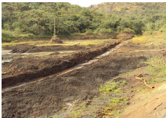
Figura 159 – Parte do leito do Córrego Elias (cocho das éguas), onde foi realizada a reconformação do leito
