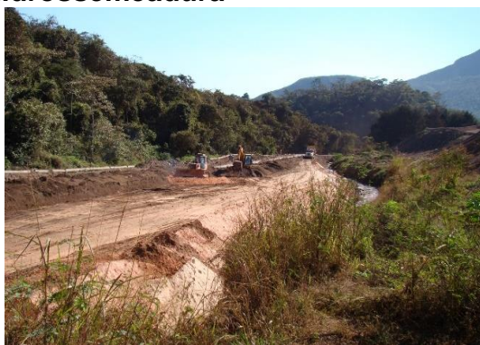
Figura 149 – Margem esquerda do Córrego Esperança à montante do TSA que foi preparada para receber o plantio de espécies arbóreas e hidrossemeadura
