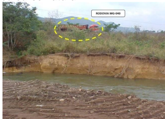
Figura 93 – Margem direita do Rio Paraopeba onde os sedimentos estavam sendo depositados como forma de proteger o barranco à margem da Rodovia MG-404, direcionando as águas do Rio para o seu curso natural
