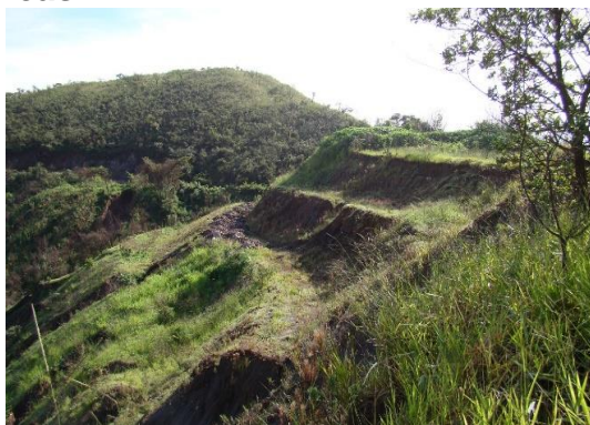
Figura 179 – Antiga pilha de estéril/rejeito na vertente revegetada do município de São Joaquim de Bicas
