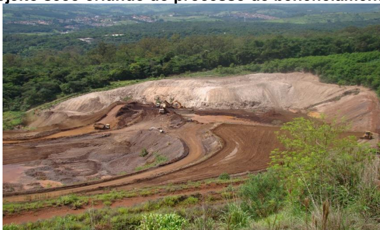
Figura 170 – Construção do primeiro banco do contrapilhamento com a utilização de rejeito seco oriundo do processo de beneficiamento
