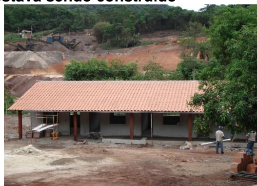
Figura 119 – Escritório auxiliar que estava sendo construído
