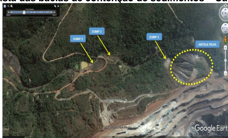
Figura 154 – Vista das bacias de contenção de sedimentos – Sumps 1, 2 e 3
