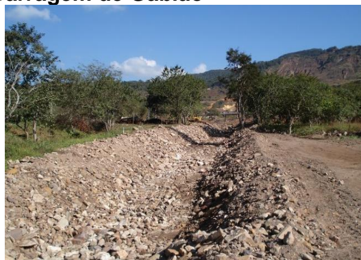
Figura 114 – Detalhe do primeiro trecho construído do novo canal do córrego esperança, à jusante da Barragem de Gabião
