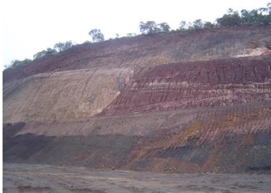
Figura 123 – Geometrização da parte oeste da cava da mina, cujas bermas foram construídas direcionando as drenagens, de forma parcelada, para as estruturas de contenção de sedimentos
