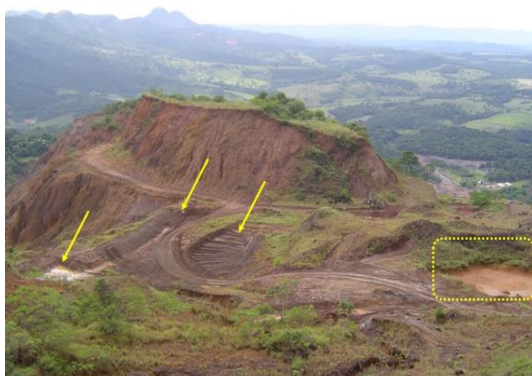
Figura 111 – Anteparos e bacias escavadas para proteger a lateral sul da cava
