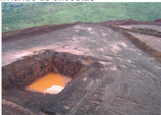
Figura 125 – Bacia escavada em outro patamar onde estava sendo realizada a geometrização da cava da mina, retendo a água incidente nessa área e aliviando as encostas
