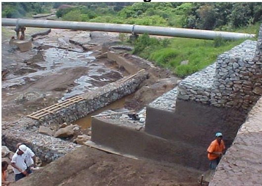
Figura 83 – Obras de recuperação e alteamento da Barragem de Gabião
