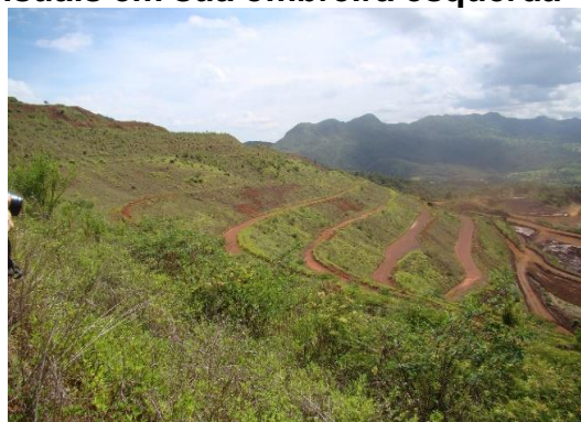
Figura 176 – Bancos e taludes da pilha de estéril/rejeito em boas condições visuais em sua ombreira esquerda
