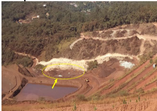
Figura 168 – No detalhe, local da instalação do dreno de fundo do contrapilhamento
