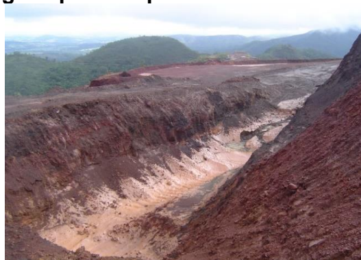
Figura 124 – Canal de drenagem que foi escavado em um dos patamares formados com a geometrização da encosta na área da cava, o que permitiu a diminuição do fluxo das águas pluviais para a cava
