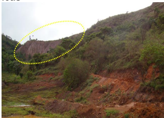
Figura 155 – Antiga pilha de rejeito/estéril localizada na vertente do Município de São Joaquim de Bicas
