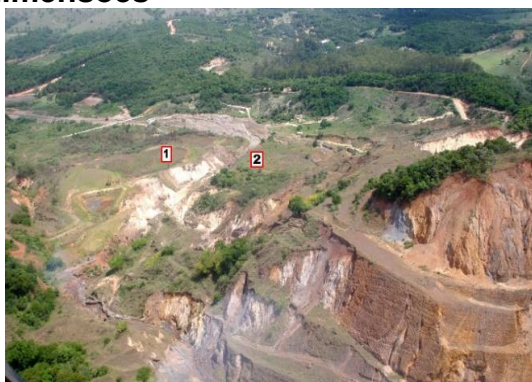
Figura 137 – Posição das antigas pilhas de rejeito (1 e 2) cortadas ao centro por uma voçoroca de grandes dimensões
