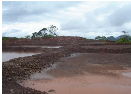
Figura 110 – Áreas de controle de drenagem pluvial, tipo terraceamentos, que foram construídos no topo da lavra para evitar fluxos nas faces desnudadas
