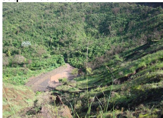
Figura 180 – Sump de contenção de sedimentos ao pé da antiga pilha de estéril/rejeito na vertente de São Joaquim de Bicas
