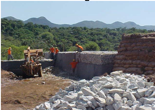
Figura 81 – Obras de recuperação e alteamento da Barragem de Gabião
