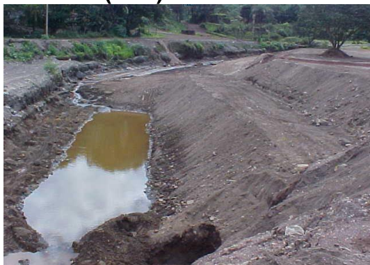
Figura 87 – Reconformação da calha do Córrego Esperança antes de passar sob a linha férrea do Terminal Serra Azul (TSA)
