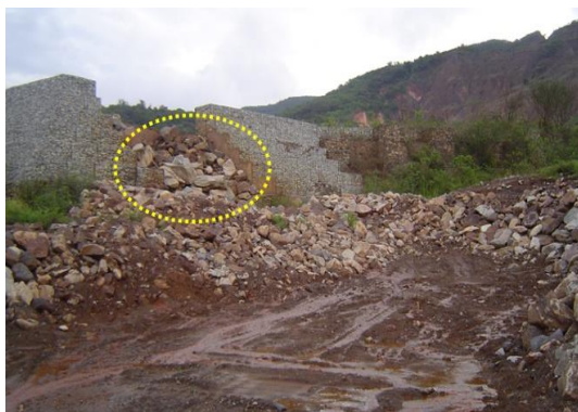
Figura 113 – Enrocamento feito na base do vertedouro da Barragem de Gabião
