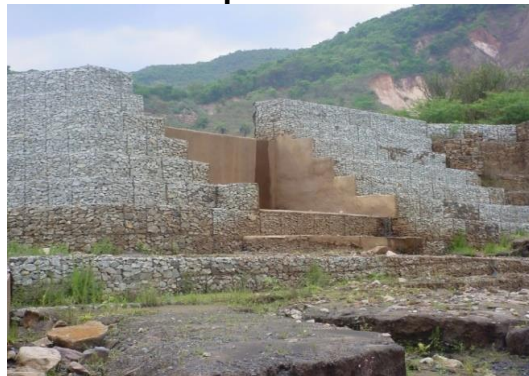
Figura 84 – Barragem de Gabião totalmente recuperada e reconstruída
