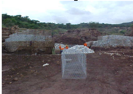
Figura 82 – Obras de recuperação e alteamento da Barragem de Gabião
