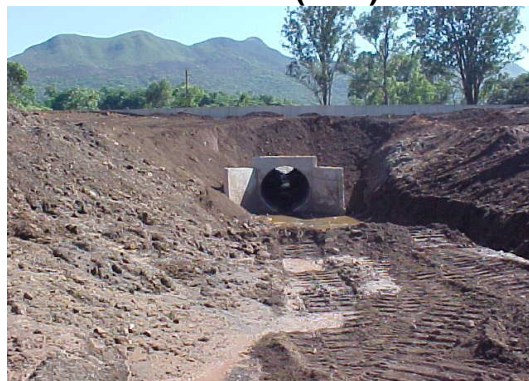
Figura 88 – Reconformação da calha do Córrego Esperança e instalação do tubo ARMCO sob a linha férrea do Terminal Serra Azul (TSA)
