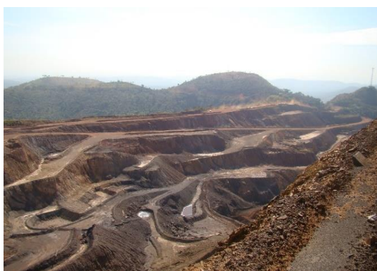
Figura 163 – Área da encosta norte do pit de lavra onde foi realizada uma geometrização, com a drenagem pluvial direcionada para o interior da cava
