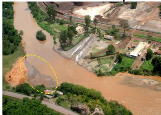
Figura 95 – Vista aérea da margem direita do Rio Paraopeba onde foi transferido todo o sedimento que formava um delta no lado oposto
