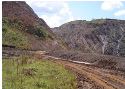
Figura 112 – Leira de proteção da drenagem, construída para evitar o fluxo das águas pluviais para o interior da cava
