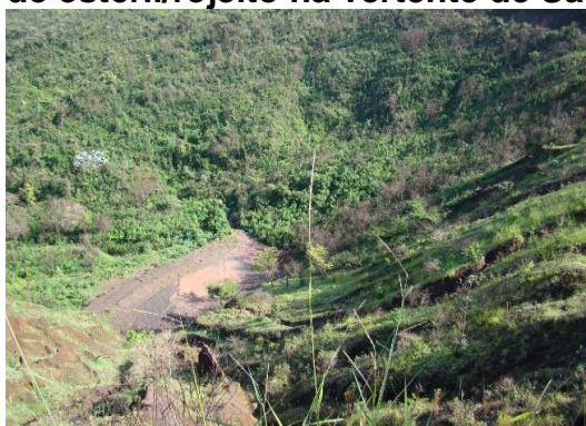
Figura 181 – Sump de contenção de sedimentos à jusante do sump localizado ao pé da antiga pilha de estéril/rejeito na vertente de São Joaquim de Bicas
