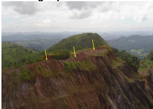
Figura 109 – Terraço construído na parte alta do morro, com várias células e materiais para a construção de leiras, com o objetivo de reduzir o fluxo de água pela encosta
