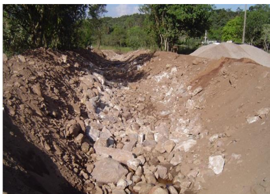
Figura 115 – Segundo trecho aberto do novo canal protegido do Córrego Esperança
