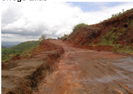
Figura 106– Leira de proteção na estrada da antiga cava, que foi construída para evitar o carreamento de sólidos para a drenagem do Córrego Elias
