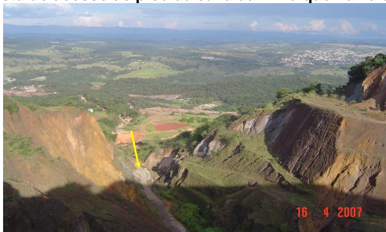
Figura 108 – Vista do acesso ao piso da cava da mina que havia sido recuperado
