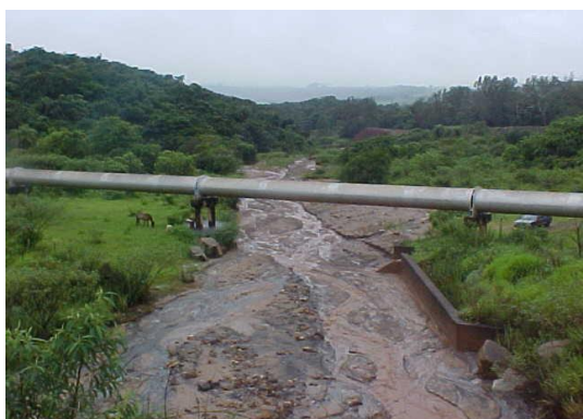
Figura 66 – Córrego Esperança imediatamente à jusante da barragem de gabião e sob a adutora da COPASA
