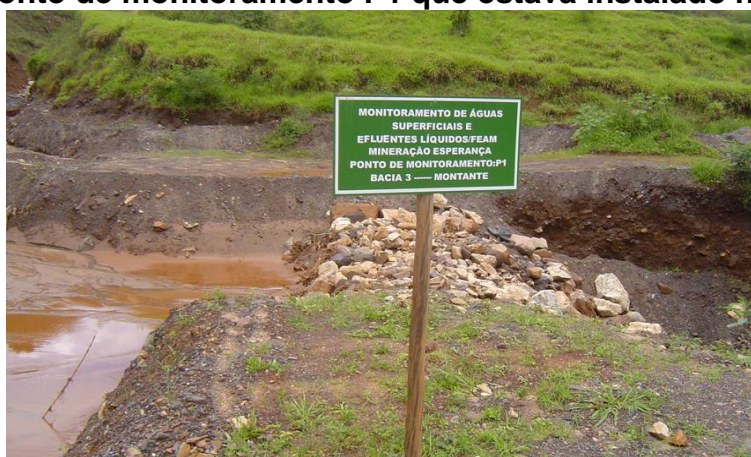
Figura 122 – Ponto de monitoramento P1 que estava instalado na Bacia 3
