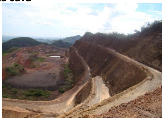
Figura 164 – Taludes em área da cava da mina com boa geometrização, e bermas direcionando o fluxo das águas pluviais para as estruturas de contenção de sedimentos no interior da cava
