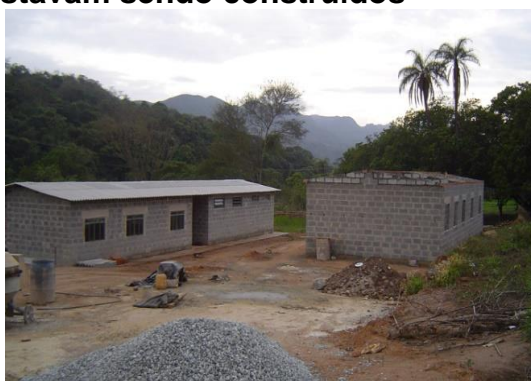
Figura 118 – Refeitório e vestiário que estavam sendo construídos
