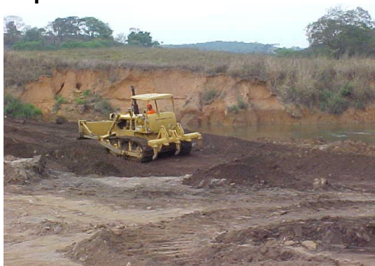
Figura 94 – Sedimentos depositados na margem direita do Rio Paraopeba, sendo devidamente distribuídos e compactados
