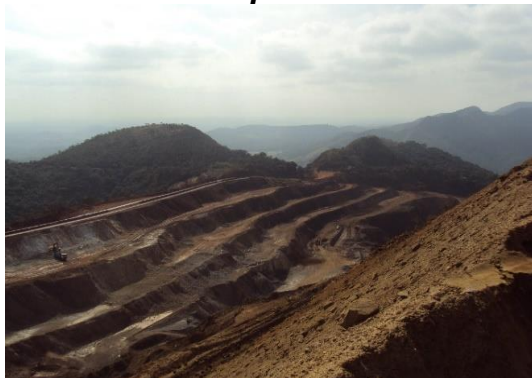
Figura 129 – Geometrização da encosta norte do pit de lavra
