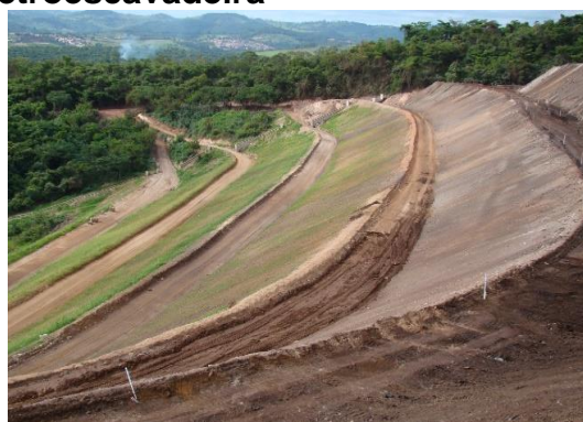
Figura 142 – Taludes que haviam sido liberados para receber o recobrimento vegetal após o rebatimento executado por retroscavadeira
