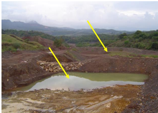
Figura 100 – Duas bacias que foram construídas e ampliadas à montante da Barragem de Gabião para o aumento da capacidade de retenção de sedimentos
