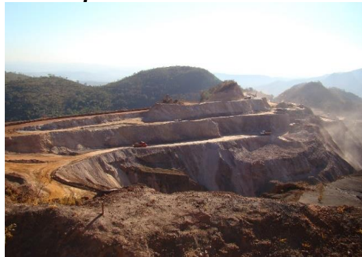
Figura 128 – Geometrização em estágio mais avançado na encosta norte do pit de lavra
