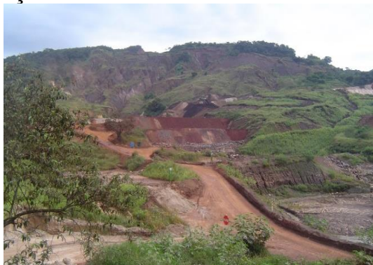
Figura 139 – Início da construção da pilha em bancadas regulares e ascendentes para preenchimento das voçorocas
