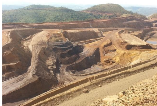
Figura 136 – Vista geral da geometrização na cava da mina onde estava sendo realizada lavra de minério de ferro
