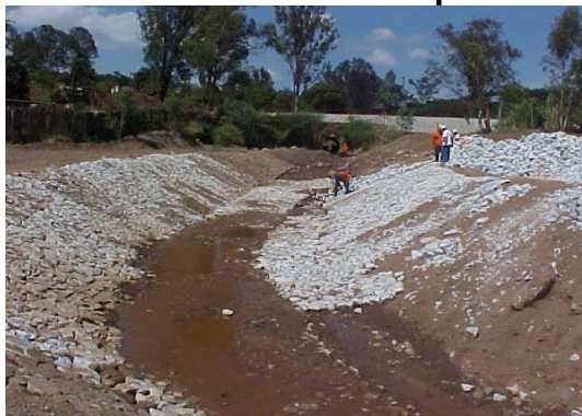
Figura 89 – Reconformação da calha do Córrego Esperança com a colocação de pedras nos taludes das margens à jusante do TSA já bem próximo à foz no Rio Paraopeba
