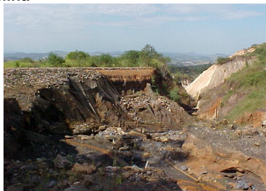
Figura 50 – Barramento construído pela COPASA para desvio das águas provenientes do interior da cava da mina
