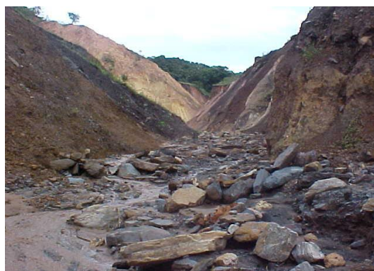
Figura 54 – Saída do canal de desvio das águas provenientes do interior da cava da mina, tendo à direita a base da pilha de estéreis e, à esquerda, a base da pilha de rejeitos
