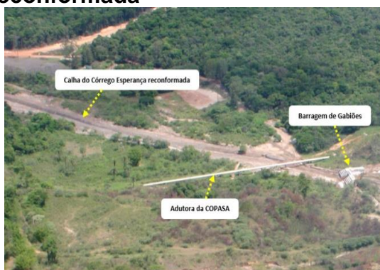
Figura 85 – Vista aérea parcial da calha do Córrego Esperança reconformada
