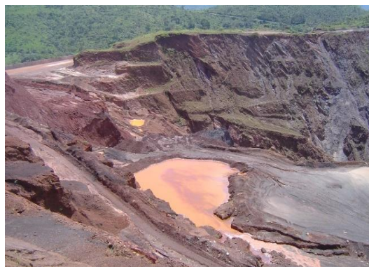
Figura 126 – Bacia ( sump ) construída no patamar logo abaixo da área geometrizada para proteger a cava à jusante
