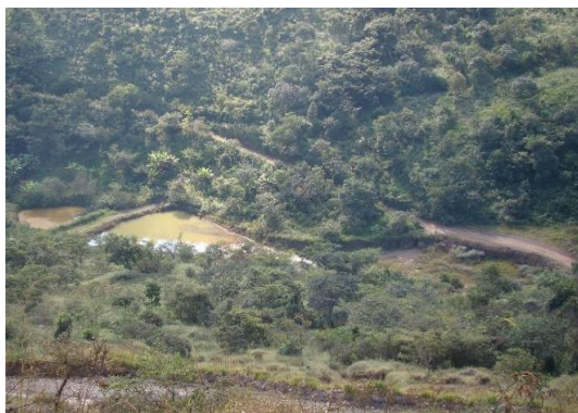
Figura 157 – Bacia de contenção de sedimentos (Sump 3)
