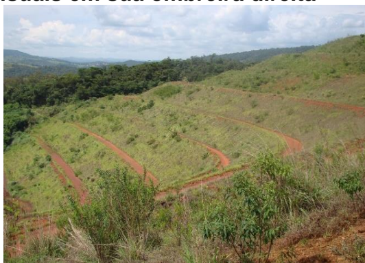
Figura 175 – Bancos e taludes da pilha de estéril/rejeito em boas condições visuais em sua ombreira direita
