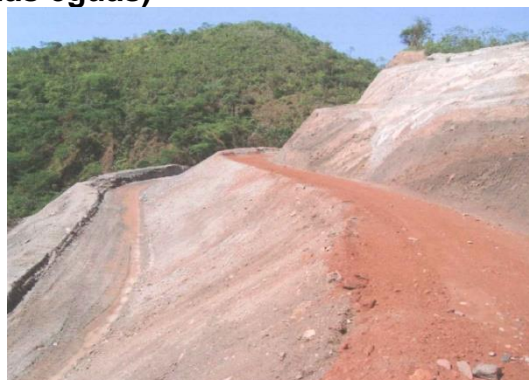
Figura 160 – Geometrização realizada na antiga pilha de rejeito/estéril na cabeceira do Córrego Elias (cocho das éguas)
