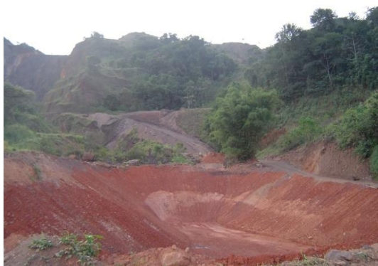
Figura 102 – Bacia construída na saída da antiga cava da mina com objetivo de reter sedimentos e impedir que eles fossem carregados para o Córrego Esperança
