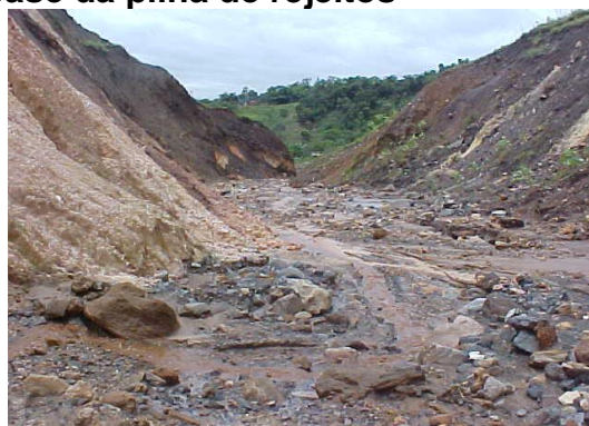
Figura 54 – Saída do canal de desvio das águas provenientes do interior da cava da mina, tendo à direita a base da pilha de estéreis e, à esquerda, a base da pilha de rejeitos
