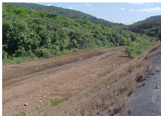
Figura 86 – Vista parcial da calha do Córrego Esperança reconformada
