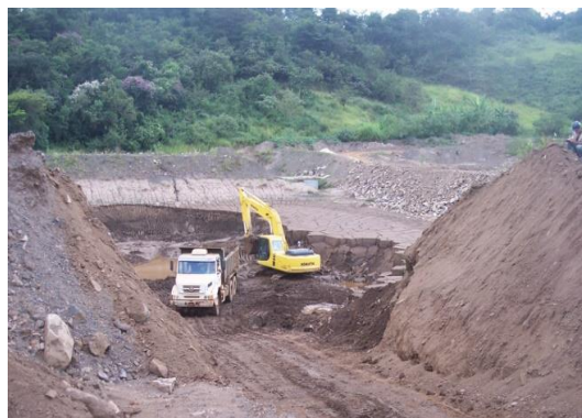
Figura 107 – Serviços de limpeza realizados na bacia de drenagem do Córrego Esperança, à jusante da antiga entrada da cava da mina
