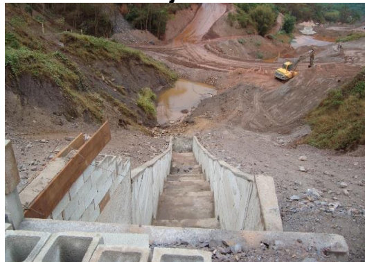
Figura 146 – Construção da escada de descida d'água na saída da primeira galeria de transposição com a bacia de amortecimento do fluxo, imediatamente à jusante
