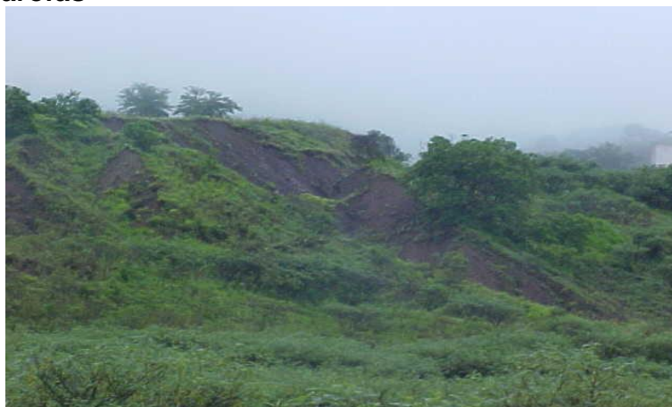
Figura 55 – Pilha de rejeitos que estava localizada na parte inferior da encosta da Serra das Farofas
