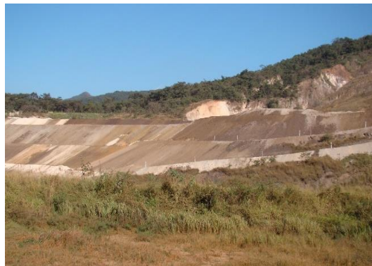
Figura 140 – Construção da pilha de forma ascendente para ocupar as feições erosivas
