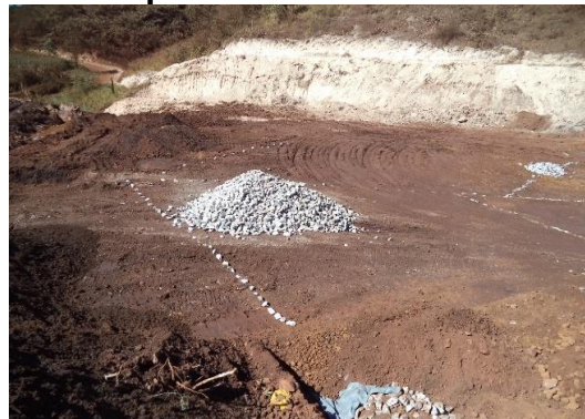
Figura 169 – Instalação das linhas da espinha de peixe do dreno de fundo do contrapilhamento
