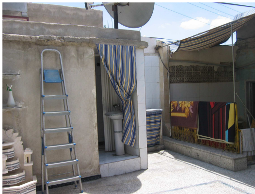
Photo 52 : Salle de bain construite sur le toit (maison n° 9, Bab el Hadid, Alep, 2008)
