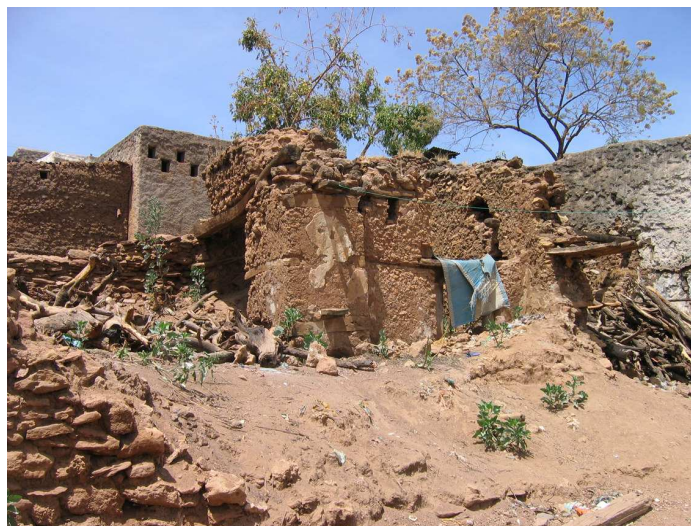
Photo 29 : Exemple de maison en ruines accolée au mur d'enceinte (SQ 05, Harar, 2008)
