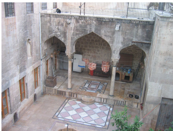
Photo 40 : Cour intérieure de la maison n°24 (Jdeideh, Alep, 2008)
