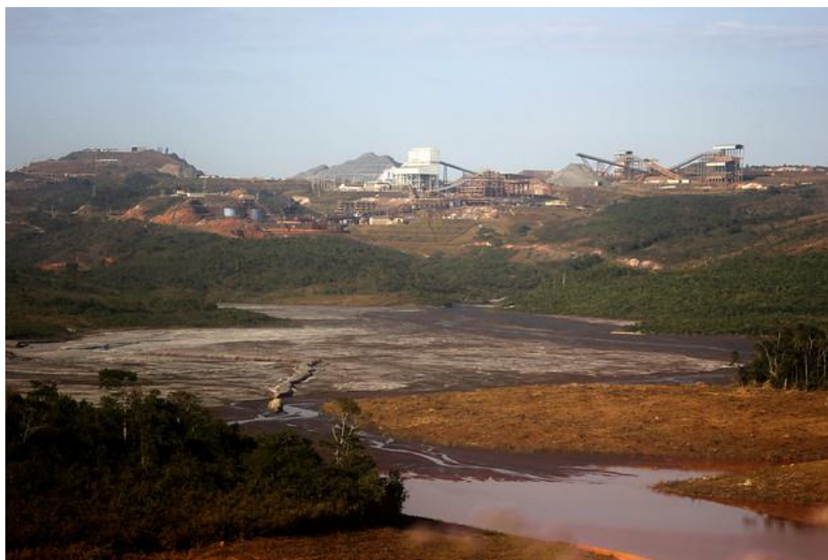
Figura 10 - Barragem de Rejeitos em Conceição do Mato Dentro, 2018.
