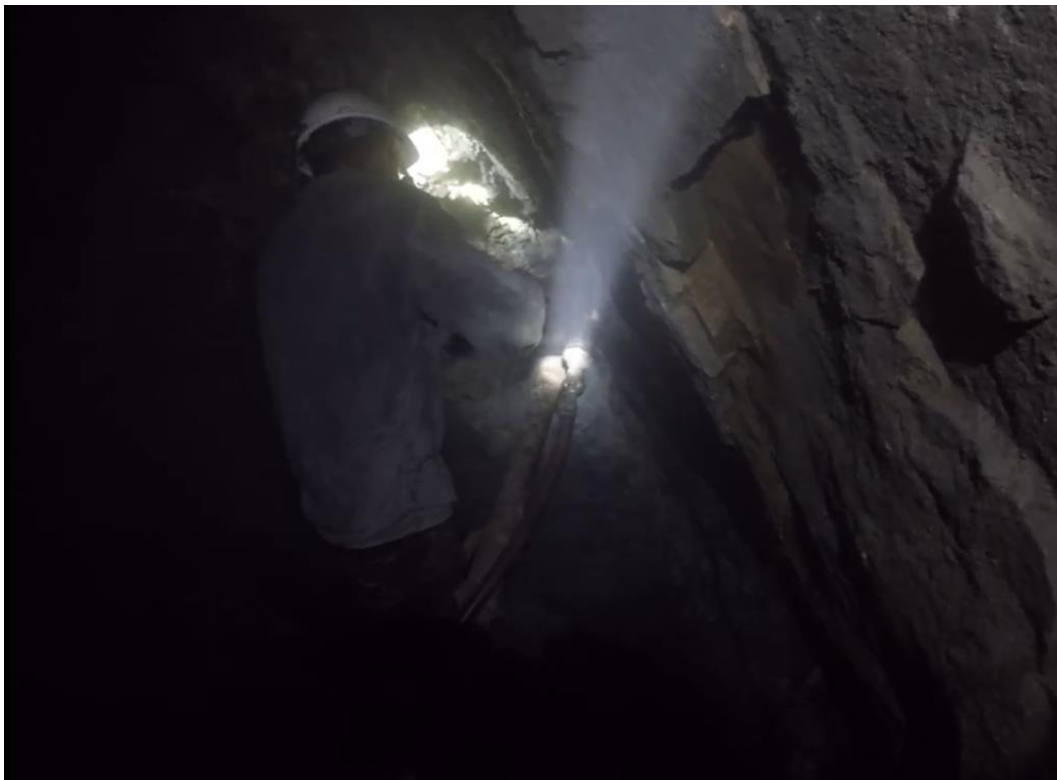
Fotografías 26: Rubén Darío abriendo huecos en la roca a través del taladro para introducir el explosivo y abrir camino.
