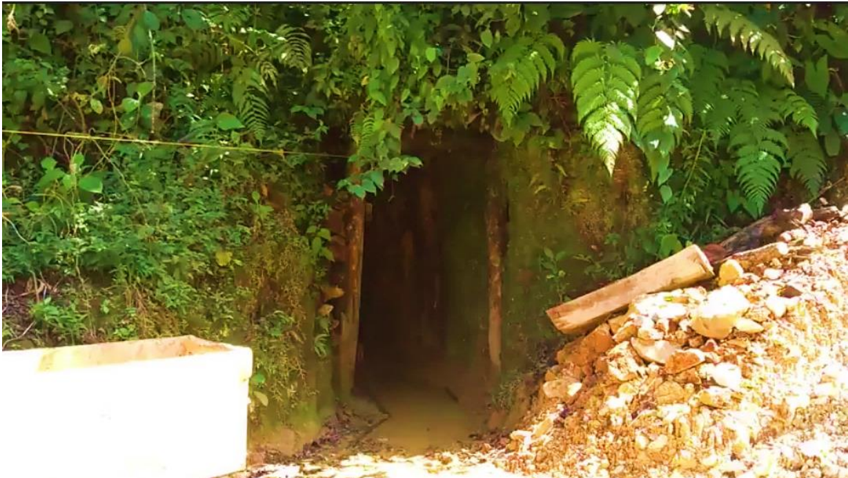
Fotografía 11: Entada de una mina ubicada en la Llorona, donde los cuadros de madera van desde el comienzo del socavón.
