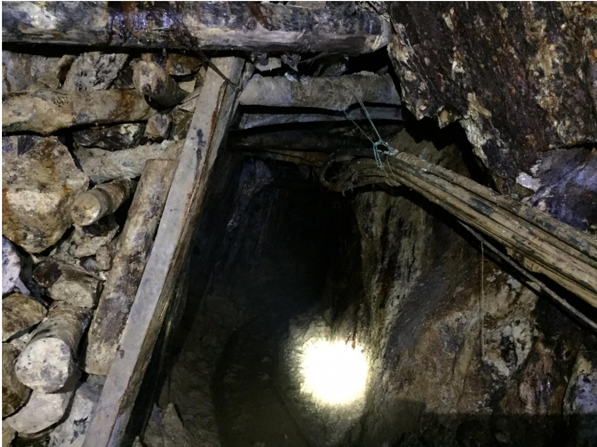
Fotografía 12: Interior de la mina Villonza. Los cuadros sosteniendo las rocas y abriendo camino a los avances de la mina. El destello del fondo es la luz de la lámpara del casco.
