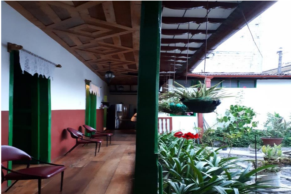
Figura 5. Corredores típicos en las casas caldenses. Imagen propia. Casa de Fabio Valencia Cardona Carrera 3 con calle 4 esquina, Manzanares, Caldas
