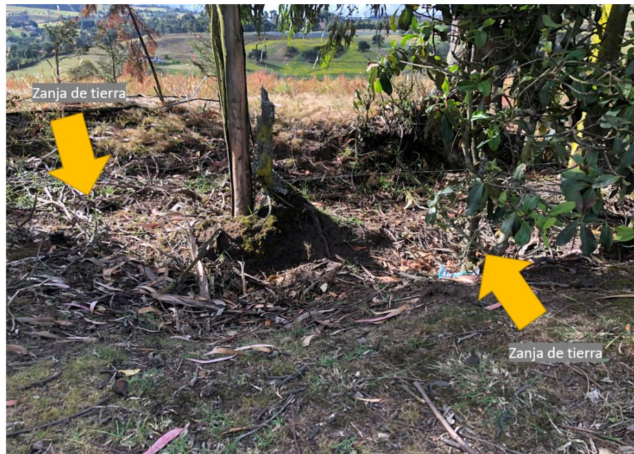
Fotografía 7. Estado de Conservación de las partes laterales de la estructura ED1.
