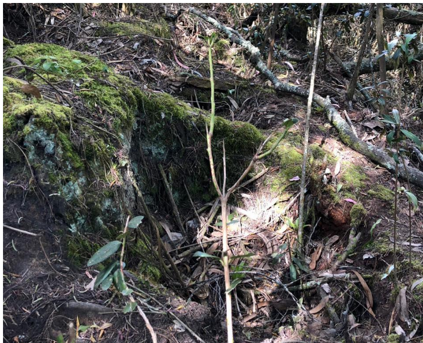
Fotografía 6. Estructuras identificadas en el campo de batalla de Santa Bárbara (ED2). Fuente: Propia (2020). Tomada por: María José Otero Alarcón.
