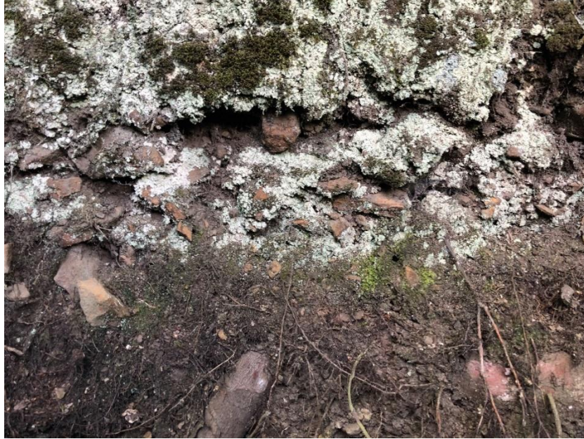
Fotografía 8. Fotografía de la pared interna de un pozo de la ED1, en el cual se aprecia la presencia de rocas y tierra como materiales utilizadas para la construcción de dicho muro. Tomado por: Valentina Rossi (2019)
