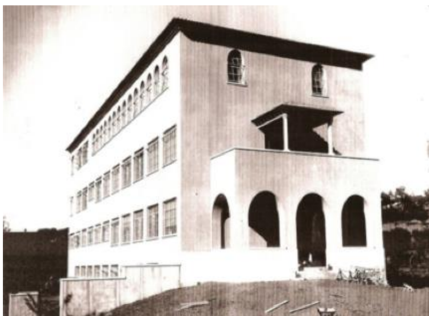
Figura 6 -Construção da 1.ª ala do Colégio em 1936 (fonte: Arquivo da Província Portuguesa do Instituto das Irmãs de Santa Doroteia).
