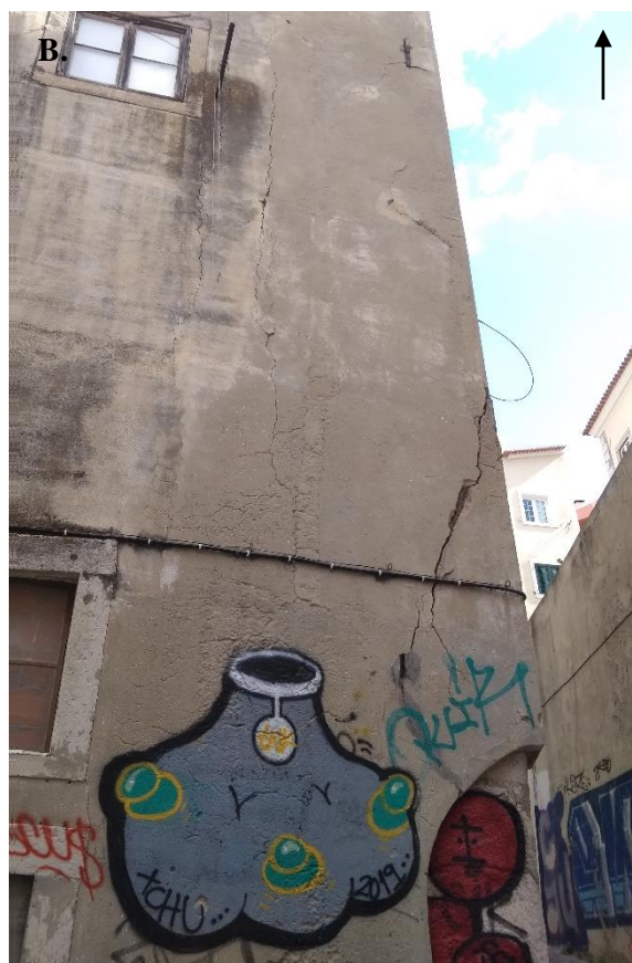
Anexo 8: Edifícios classificados na classe de patologias II, evidenciando a presença de fendas. A. Vila do Castelo, nº1-7; B. Rua da Achada, nº2-4; C. Beco das Canas, nº3-5 (destaque para as setas com a direcção aproximada do ponto cardinal Norte).
