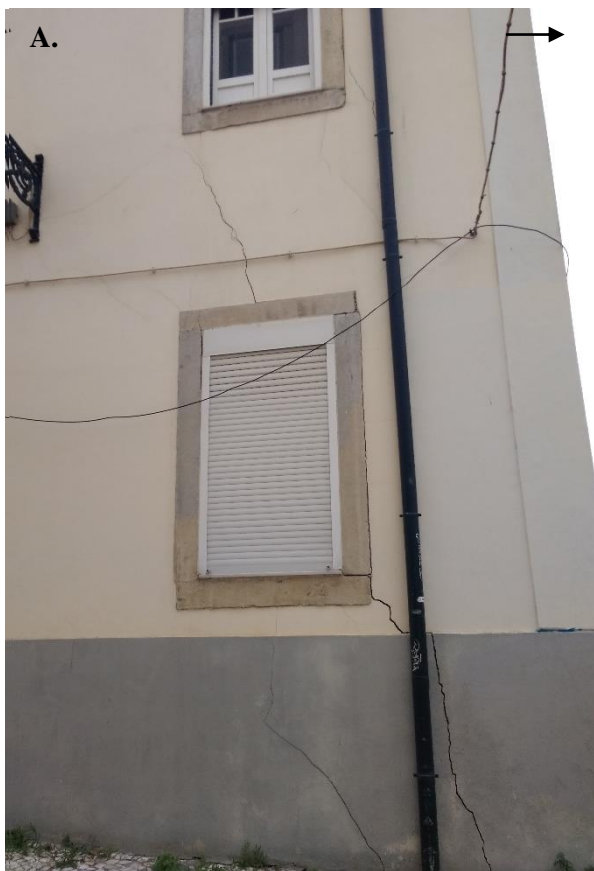
Anexo 8: Edifícios classificados na classe de patologias II, evidenciando a presença de fendas. A. Vila do Castelo, nº1-7; B. Rua da Achada, nº2-4; C. Beco das Canas, nº3-5 (destaque para as setas com a direcção aproximada do ponto cardinal Norte).
