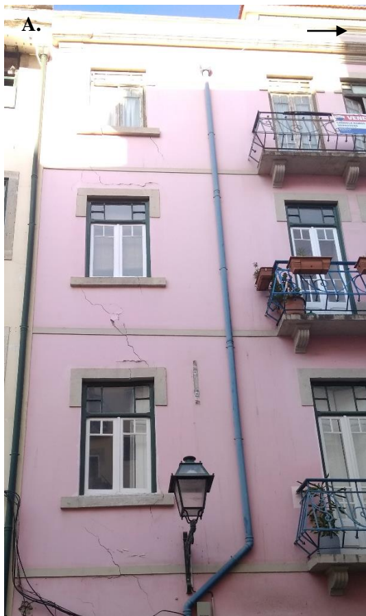
Anexo 6: Edifícios classificados na classe de patologias I, evidenciando a presença de fissuras. A. Rua do Benfornoso, nº93-99; B. Largo do Trigueiro, nº2-5; C. Calçadinha de São Miguel, nº32; D. Calçadinha de São Miguel, nº34 (destaque para as setas com direcção aproximada do ponto cardinal Norte).
