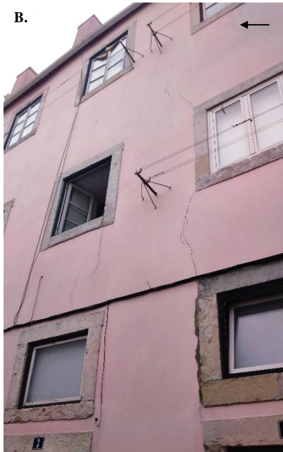
Anexo 6: Edifícios classificados na classe de patologias I, evidenciando a presença de fissuras. A. Rua do Benfornoso, nº93-99; B. Largo do Trigueiro, nº2-5; C. Calçadinha de São Miguel, nº32; D. Calçadinha de São Miguel, nº34 (destaque para as setas com direcção aproximada do ponto cardinal Norte).
